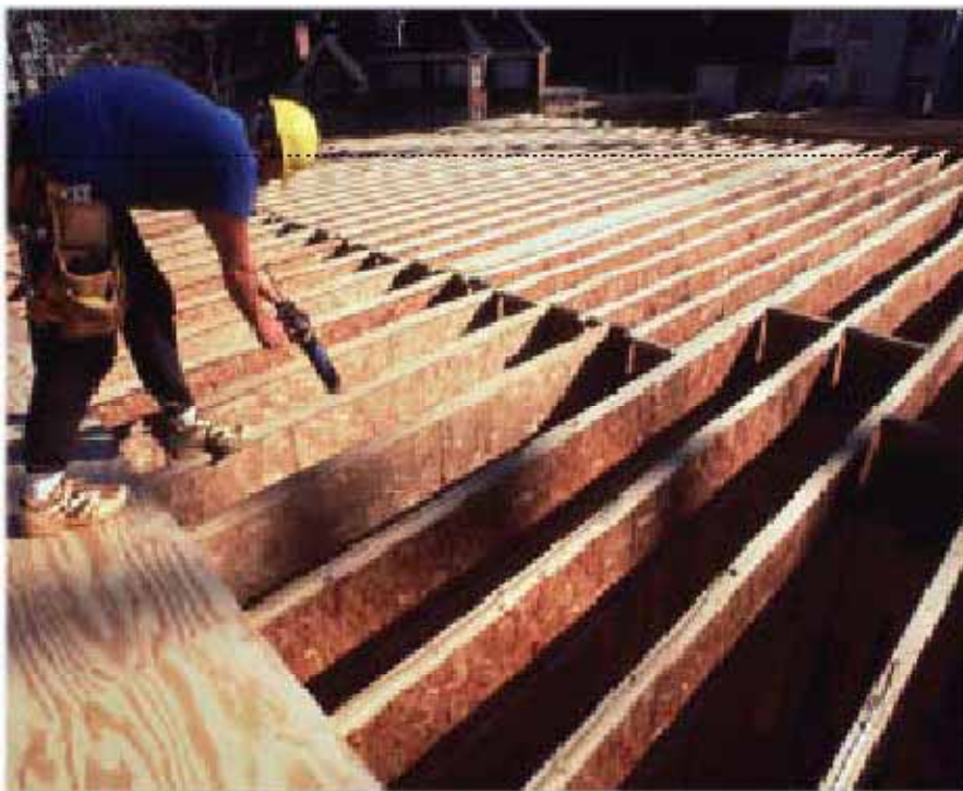
Figura 14: Ligações coladas. Fonte: Engineered Wood Products (2001) apud Duarte (2004).
