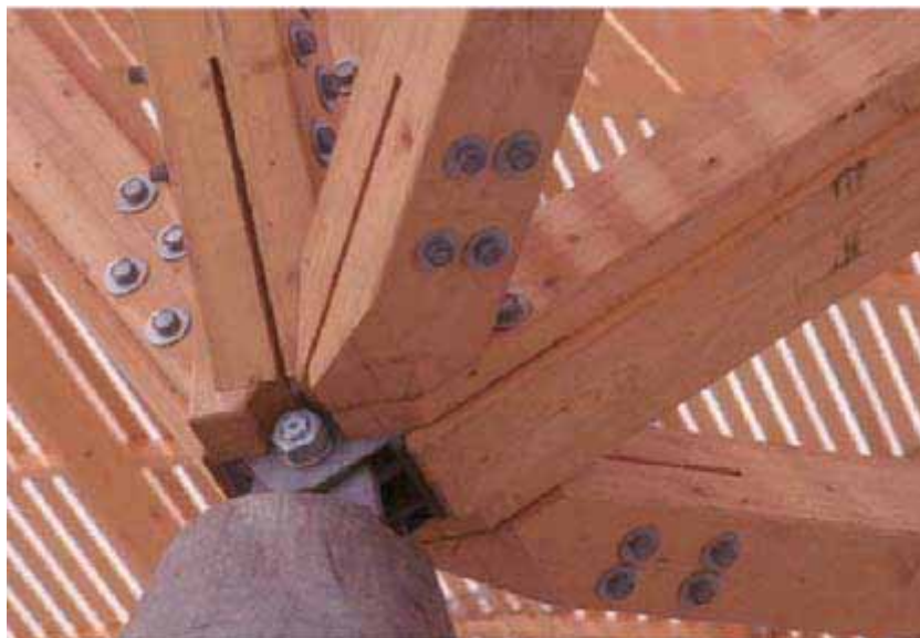
Figura 1: Ligações por conectores metálicos. Fonte: Flach; Frenette (2000) apud Duarte (2004).
