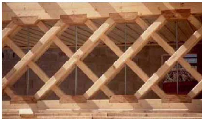
Figura 13: Ligações por contato. Fonte: Flach; Frenette (2000) apud Duarte (2004).
