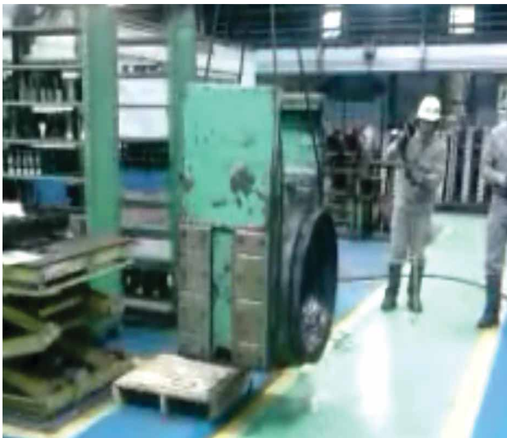
Figura 14 – Transporte do mancal do DUO 900 para a montagem com a utilização da ponte rolante (Fonte: GSP)
