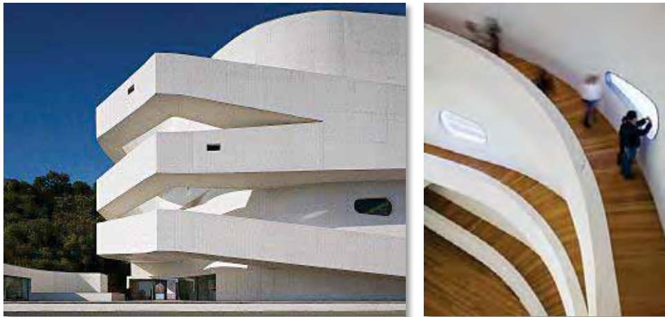
Foto 71: Vista externa das rampas contínuas.
