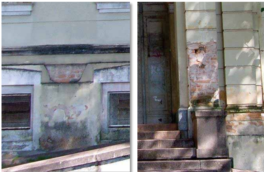
Foto 57: Estrutura exposta na fachada.
