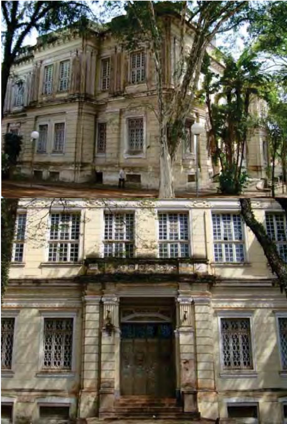
Foto 40: Fachada Fórum – Avenida General Telles Foto 41: Acesso lado Fórum
