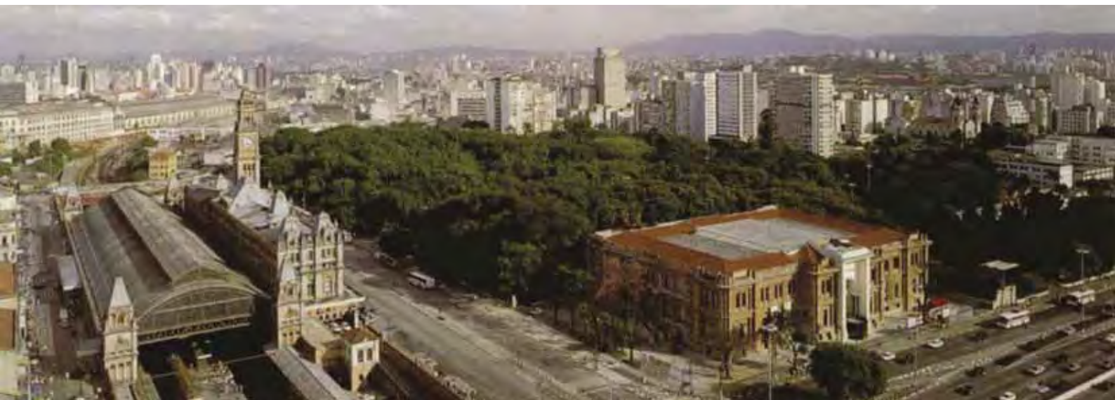
Foto 67: Vista aérea da Pinacoteca com a Estação da Luz. Fonte: ROCHA, 2006.
