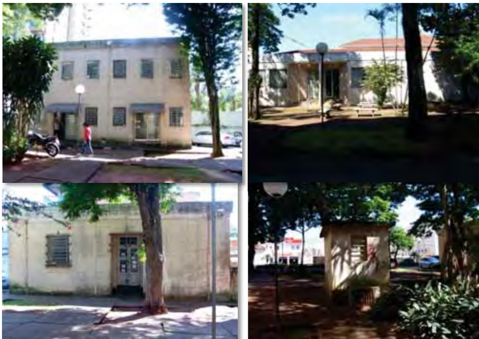
Foto 53, 54 e 55: Cartório na Praça Rui Barbosa. Foto 56: Outra edificação.
