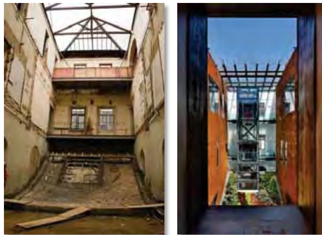
Foto 64: Pátio interno durante a construção .
