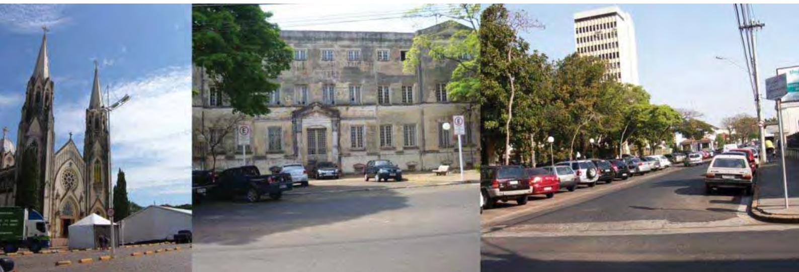
Foto 74: Frente da catedral permanesse com paralelepípedo. Foto 75: Frente do Fórum é asfaltada.
