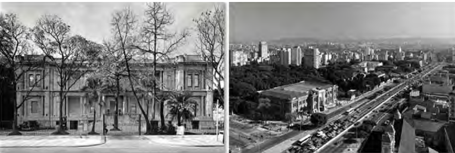
Foto 2: Fachada principal. Foto 3: Pinacoteca no contexto urbano. Fonte: MÜLLER (2000).
