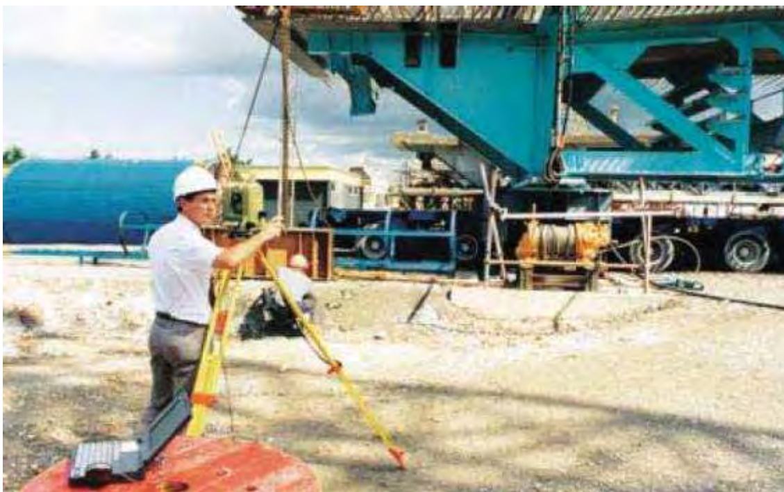
Figura 11 - Medição da seção de um navio durante a fabricação (VIEIRA, 2003).
