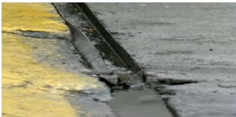
Figura 8 - Danificações nas canaletas de postos retalhistas.
