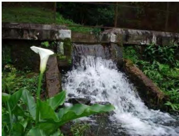
Figura 4-9: Vista geral da captação do Ribeirão dos Lemes (Fonte: http://www.saeg.guaratingueta.sp.gov.br )
