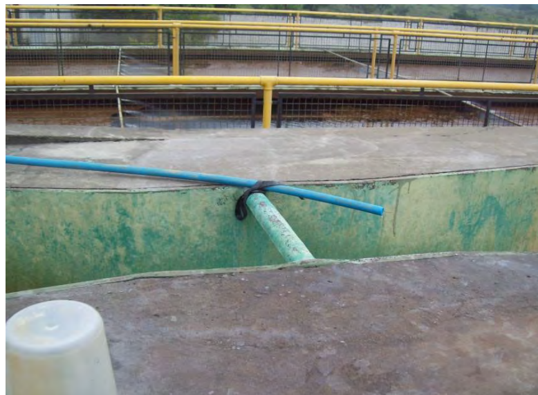
Figura 4-16: Detalhe da mangueira utilizada para adicionar PAC à água
