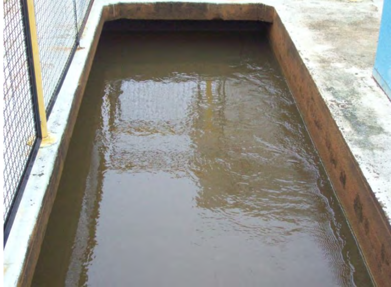
Figura 4-17: Tanque de Flocculação
