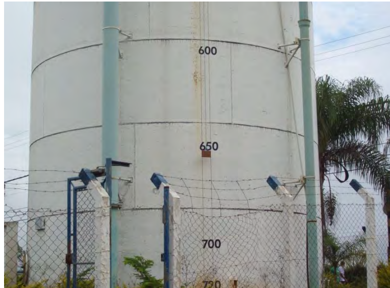
Figura 4-38: Representação do marcador e da tubulação ladrão no REL-7
