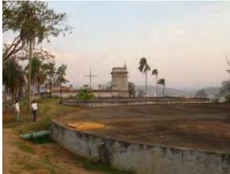
Figura 4-35: Visão geral do CR Pedregulho (Fonte: http://www.saeg.sp.gov.br )
