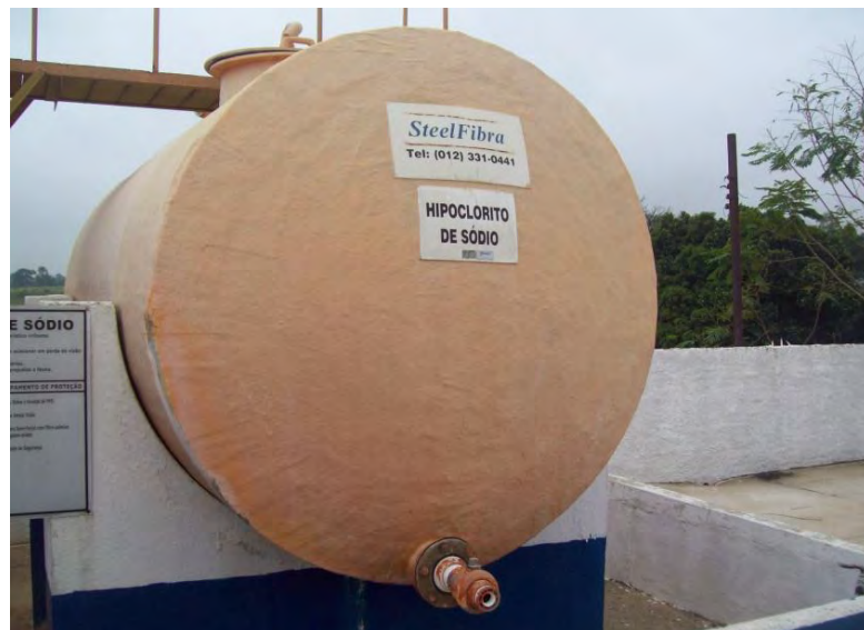
Figura 4-28: Tanque com Hipoclorito de Sódio
