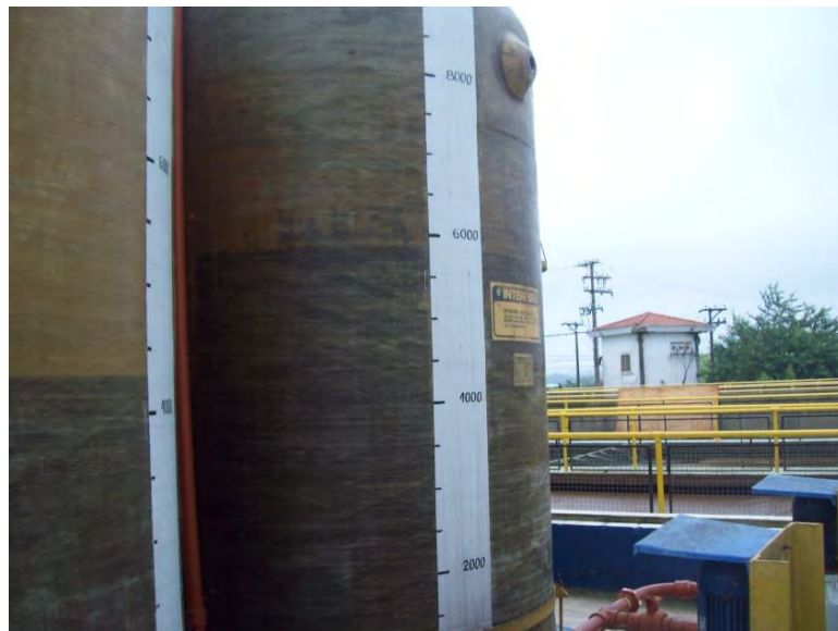
Figura 4-26: Tanque para armazenamento do PAC
