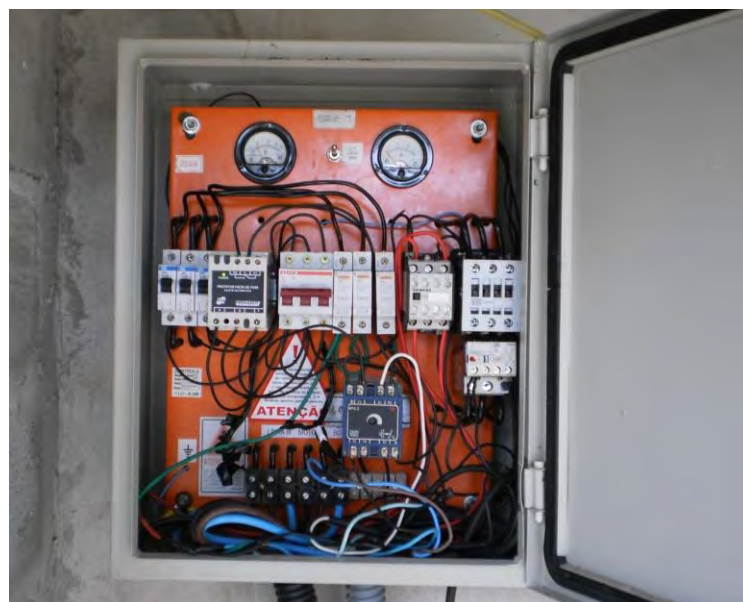
Figura 4-5: Painel da Bomba d'Água
