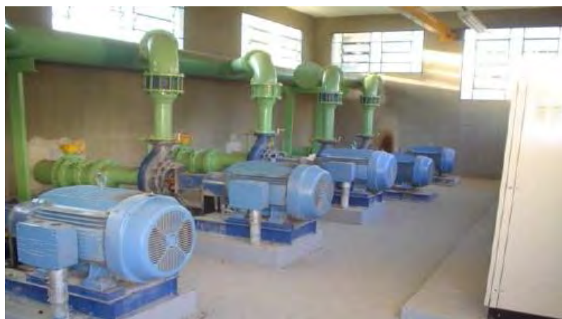
Figura 4-34: Detalhes da EEAT na Casa de bombas (Fonte: http://www.saeg.sp.gov.br )
