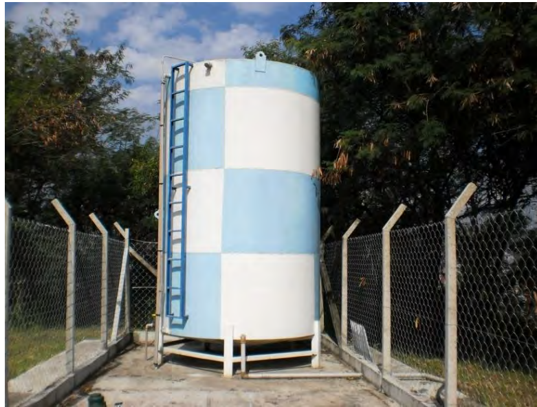
Figura 4-7: Reservatório de água
