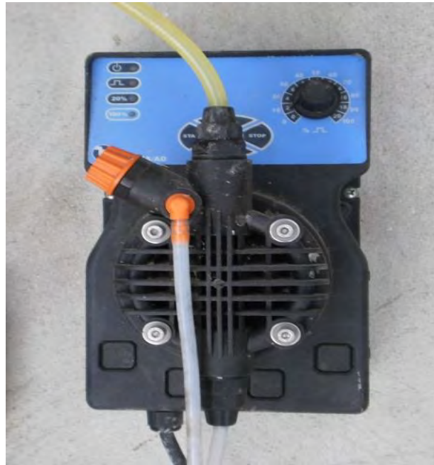
Figura 4-2: Bomba dosadora de cloro
