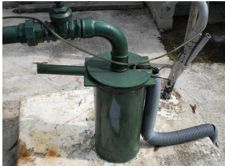
Figura 4-3: Captação de água do Poço Artesiano
