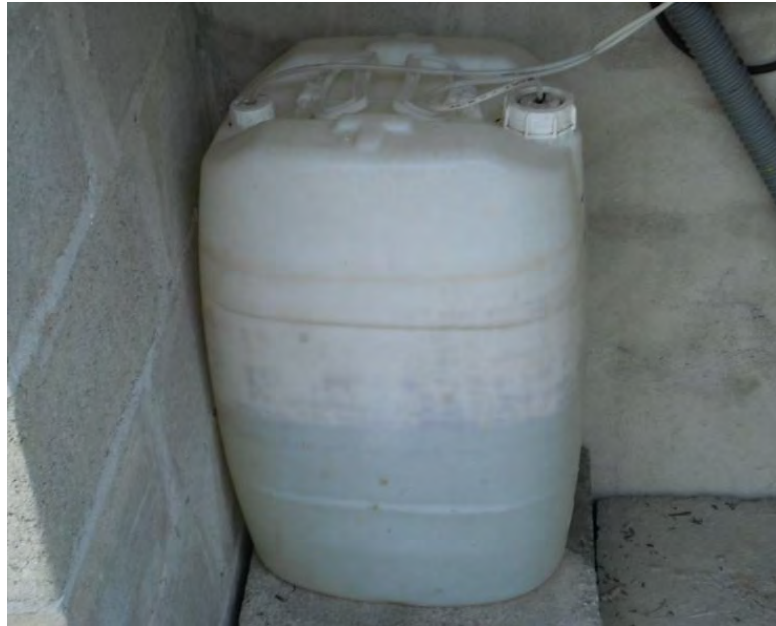
Figura 4-1 Bombona contendo hipoclorito de sódio de 12% a 14% diluído na proporção de 1:1 em água tratada
