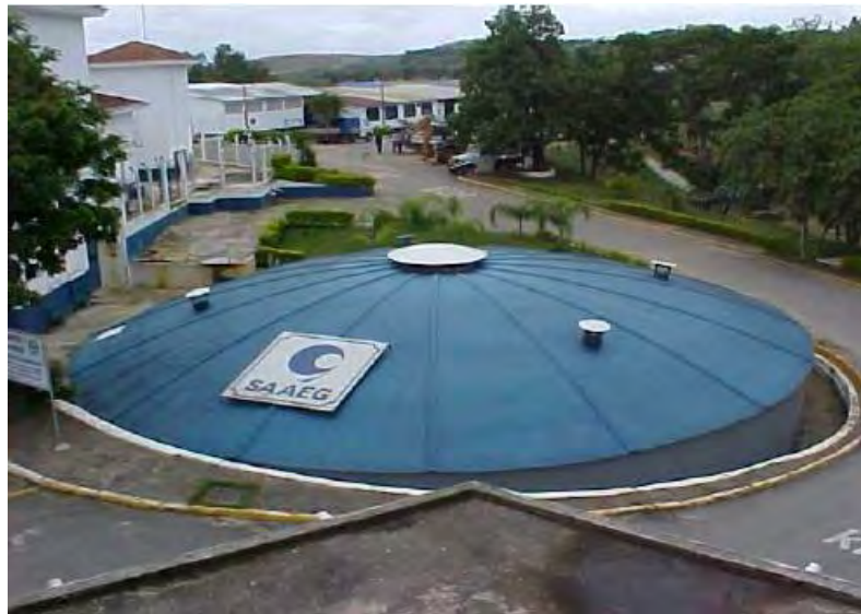
Figura 4-33: Vista do Reservatório R1, poço de sucção da EEAT e ETA (Fonte: http://www.saeg.sp.gov.br )
