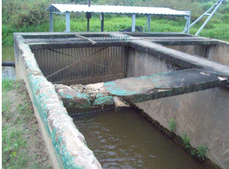
Figura 4-11: Vista da caixa de areia
