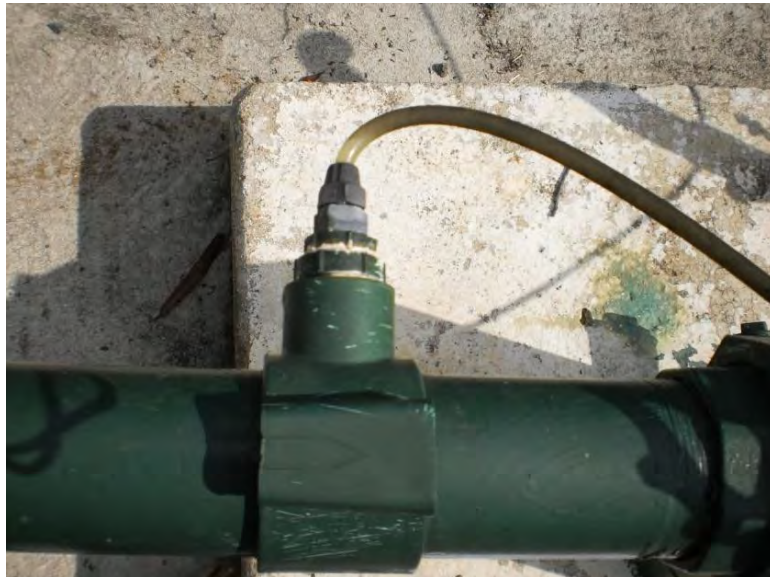
Figura 4-4: Representação do ponto de entrada da solução de hipoclorito de sódio diluída
