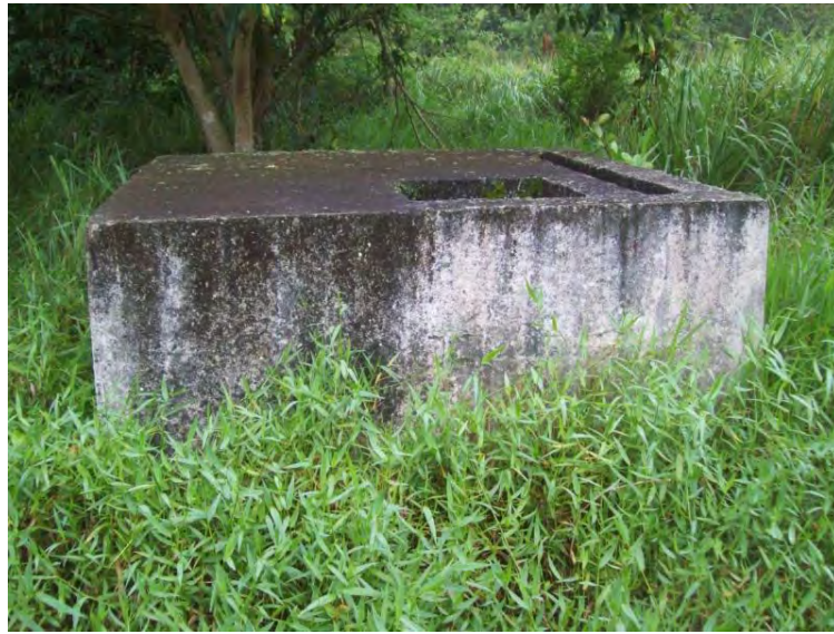
Figura 4-12: Vista da Caixa de Inspeção
