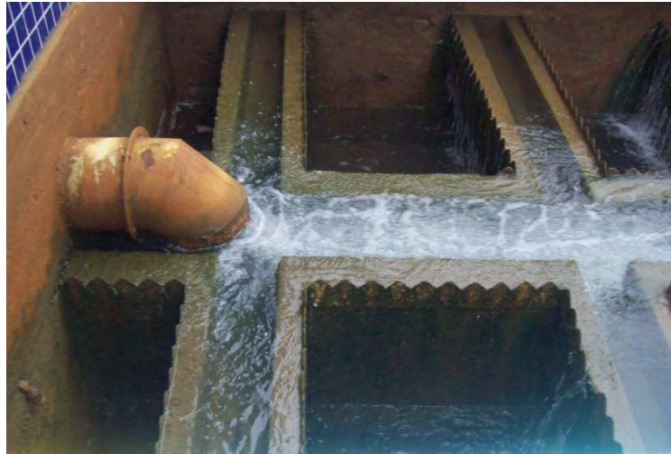
Figura 4-21: Vista da Galeria
