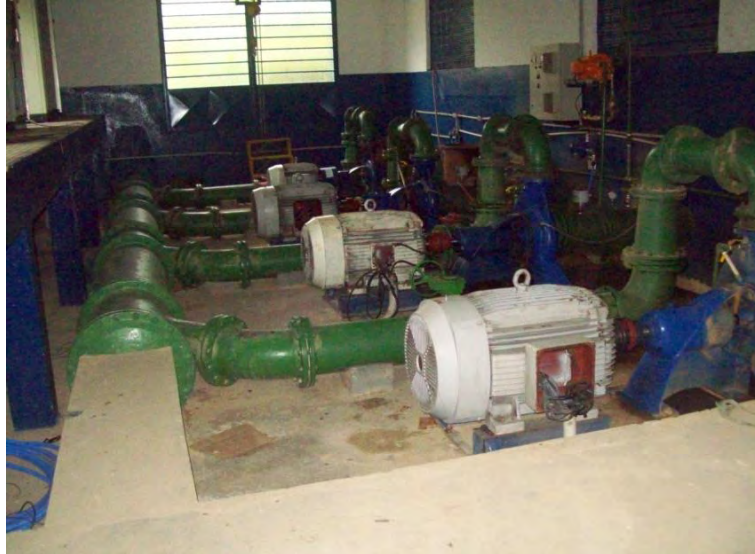
Figura 4-14 : Conjunto de moto-bombas na EEAB
