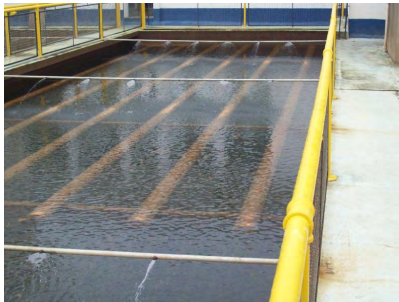
Figura 4-20: Vista dos filtros
