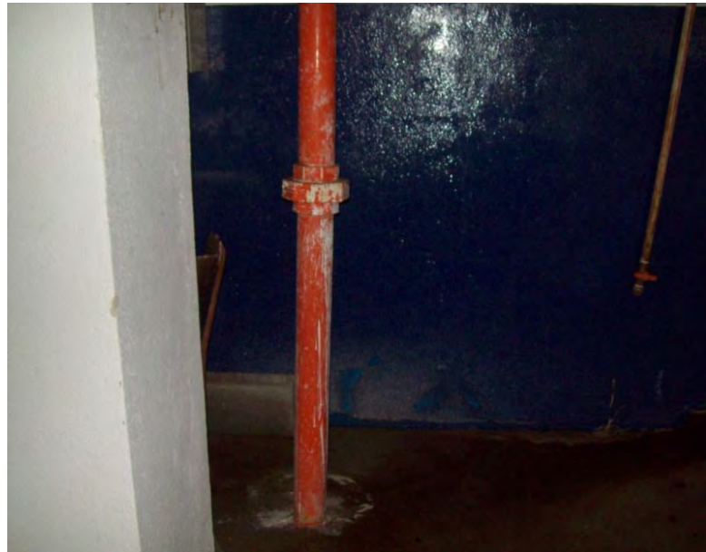
Figura 4-31: Vista da tubulação onde o cal é misturado à água
