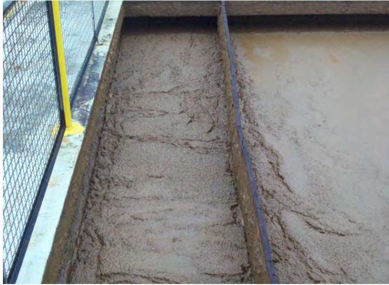
Figura 4-18: Tanque de Decantação
