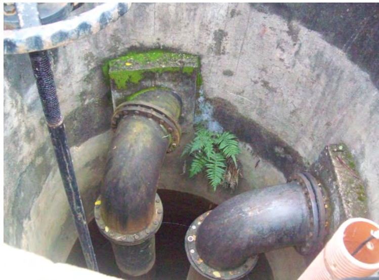
Figura 4-13: Vista de cima do Poço de Sucção.
