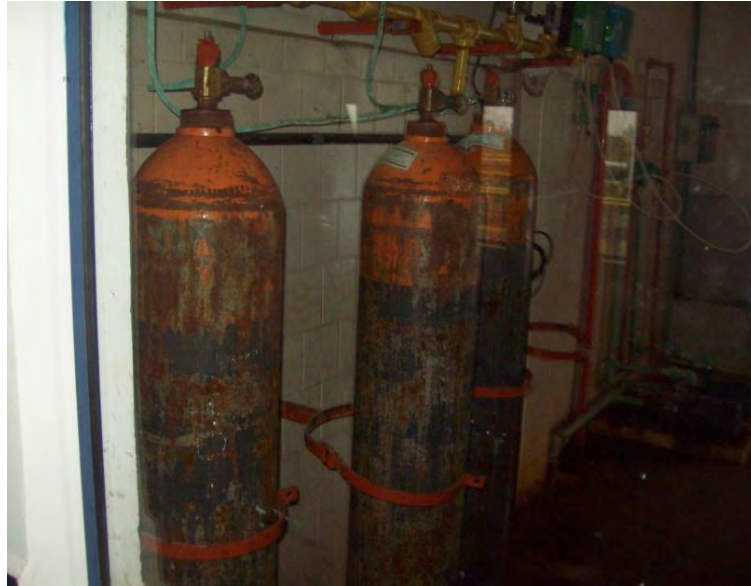
Figura 4-23: Cilindro de cloro a gás
