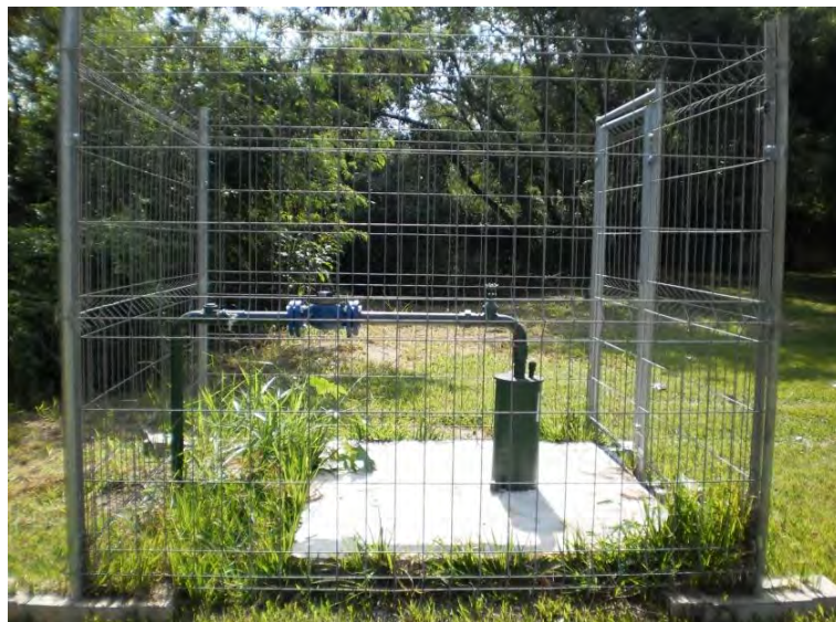
Figura 4-8: Novas instalações: Poço Artesiano nº II
