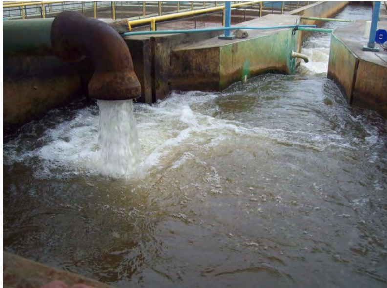
Figura 4-15: Chegada da água à ETA e mistura ao policloreto de alumínio
