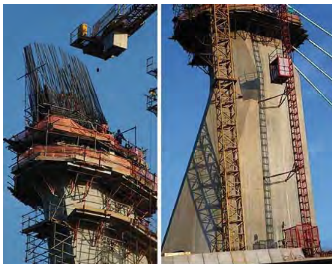
Sistema de Ponte Estaiada _detalhe do mastro Junção do concreto e aço Arq. Alexandre Chan - RJ
