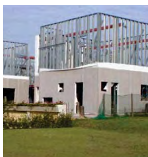
Placa cimentícia e detalhe de aplicação
