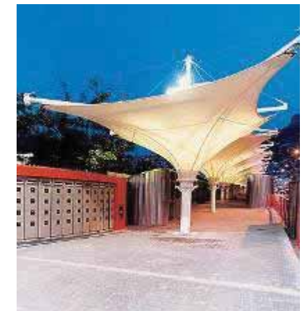
Foto 4 - Estrutura da cobertura
