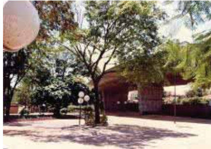
Foto 21 - Viaduto Tanel Abbud (1986)
