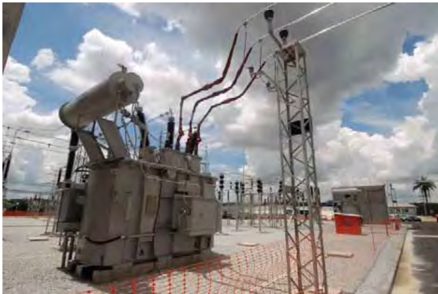
Figura 9: Transformador principal
