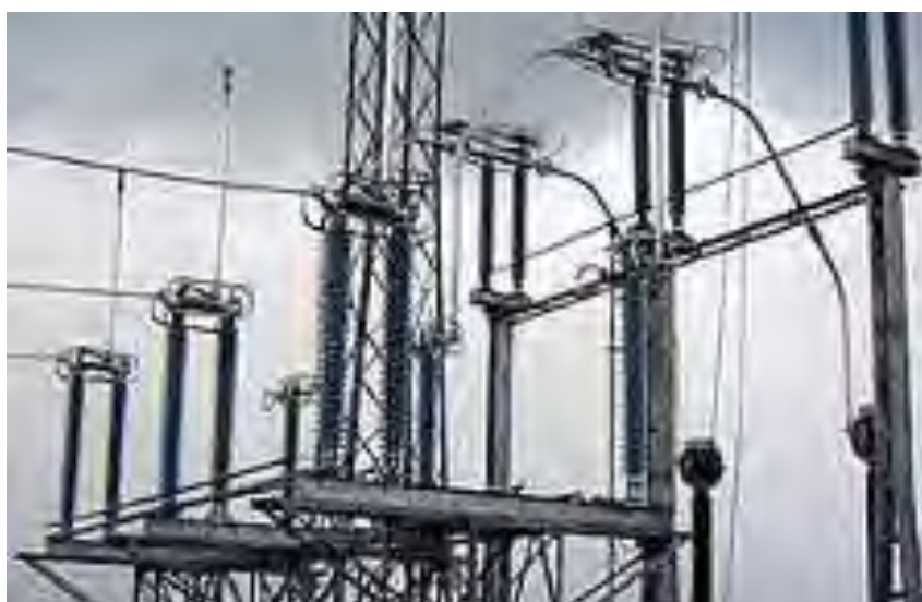
Figura 5: Chave Seccionadora
