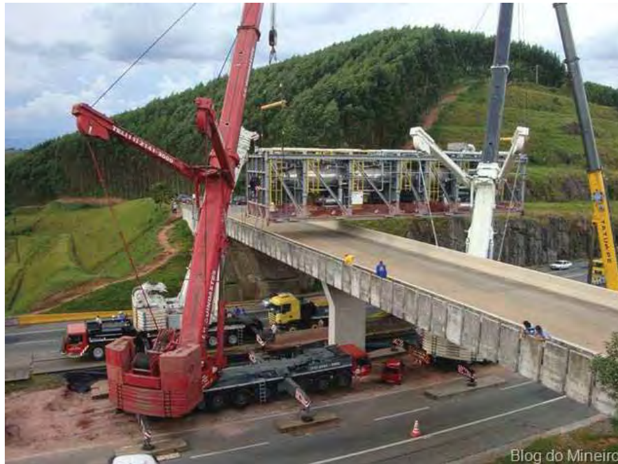
FIGURA 4 – Carreta excede altura máxima de viaduto e é necessária a passagem da carga sobre o mesmo (Fonte: RAC, 30/03/2011)
