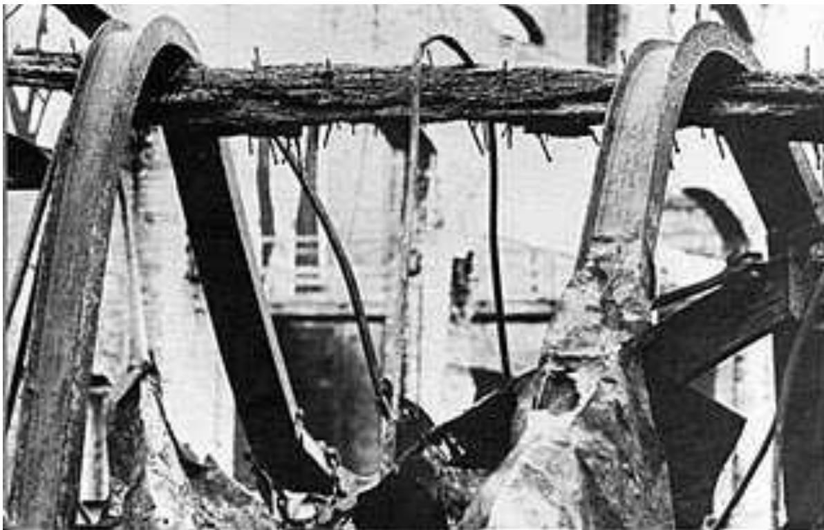
Figura 10 - Foto de incêndio onde uma estrutura de madeira e aço estavam expostos sobre as mesmas condições.
