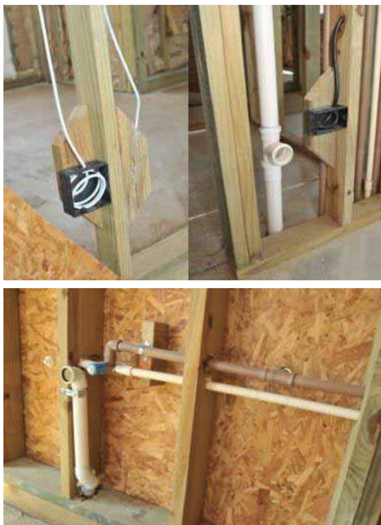
Figura 33 - Instalações elétrica e hidráulica de residência em wood-frame. Fonte: Do autor.
