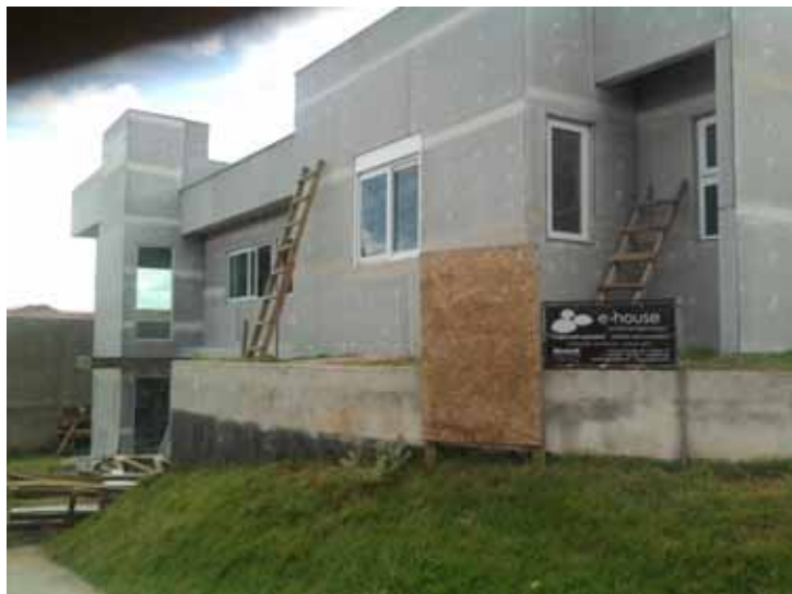
Figura 37 - Acabamento externo em chapas cimentícia, não finalizado. Fonte: Do autor.
