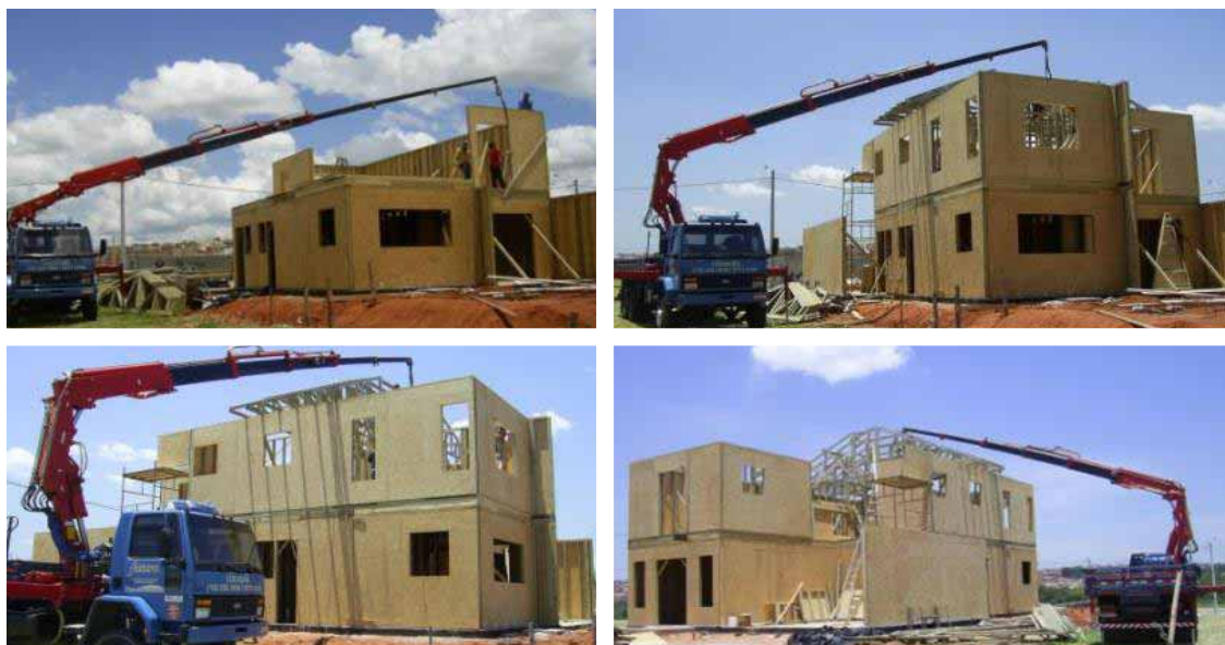
Figura 24 - Montagem de estrutura em wood-frame .
