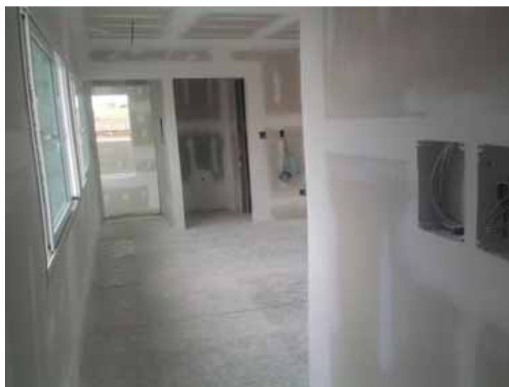
Figura 38 - Acabamento interno com gesso acartonado, não finalizado. Fonte: Do autor.
