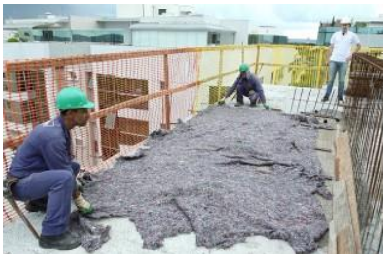
Figura 18 – Laje sendo coberta com plásticos para não prejudicar a cura do concreto
