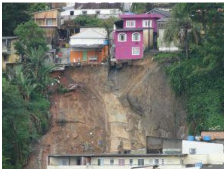
Figura 02 – Casas construídas em encostas
