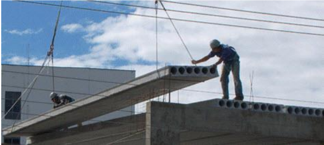
Figura 35 – Lajes pré-fabricadas de concreto protendido
