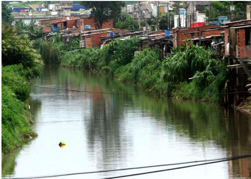
Figura 01 – Casas com alto risco de enchentes e alagamentos
