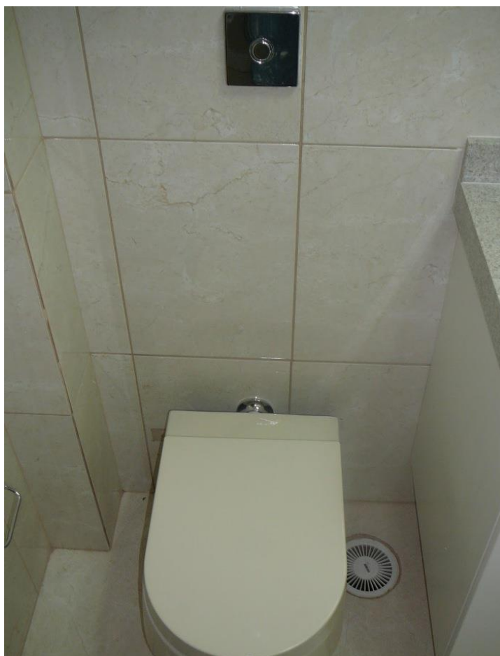
Figura 74 – Vaso sanitário com válvula de descarga
