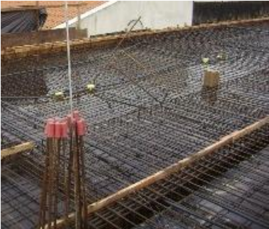
Figura 34 – Laje maciça de concreto armado
