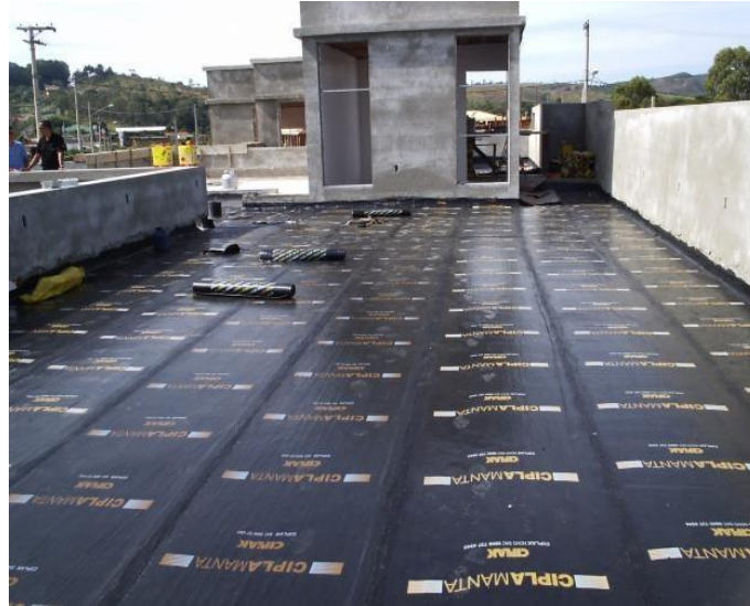
Figura 39 – Laje impermeabilizada com manta asfáltica
