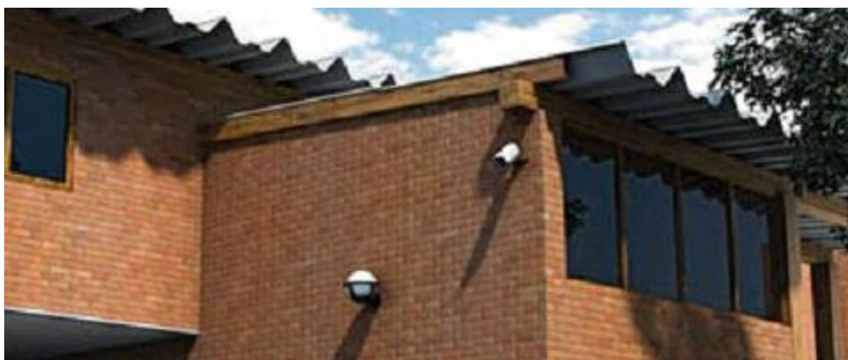
Figura 41 – Cobertura feita com canaletes estruturais
