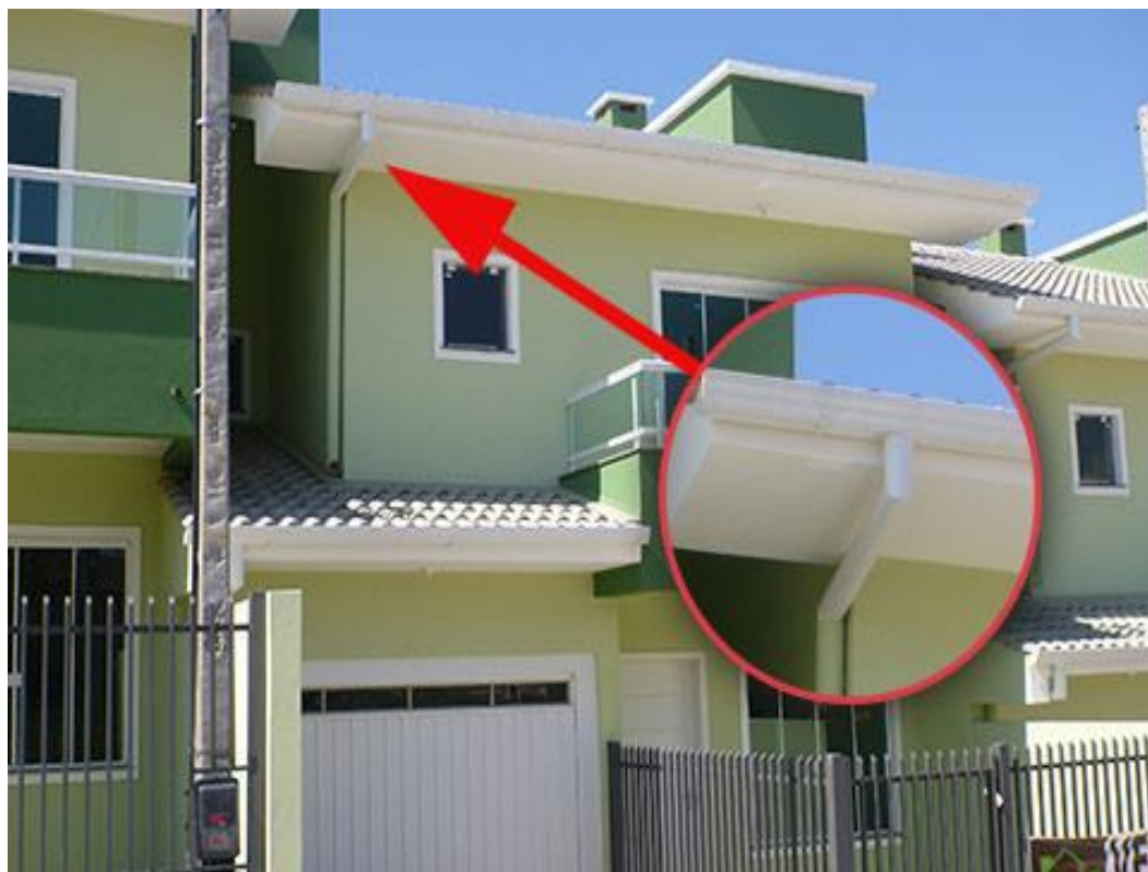
Figura 82 – Calhas e condutores
