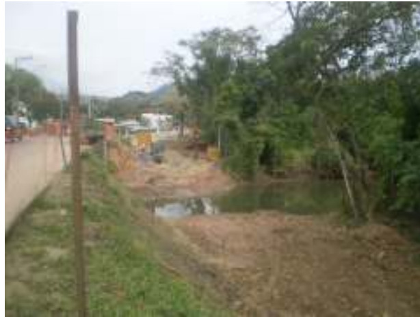
Figura 20: Obra de duplicação da ponte sobre o córrego da Água Branca, suprimindo área de mangue (fev. de 2011). Fonte:Acervo do autor.
