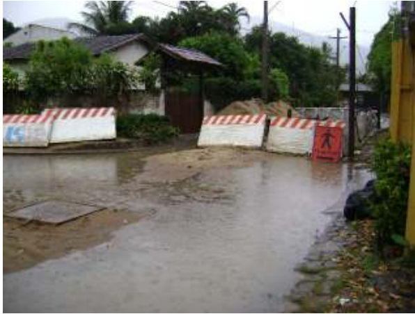
Figura 16: Obras da Sabesp de ampliação da rede de esgoto (fev. de 2011). Fonte: Acervo do autor.
