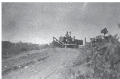
Foto 1: Ponte sobre a ferrovia, ligava os dois lados da cidade separados pela estrada de ferro. Fonte: Acervo Museu Histórico “Manoel Francisco de Oliveira”, s.d
