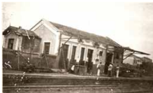
Foto 2: Prédio da estação ferroviária em construção, 1920.
