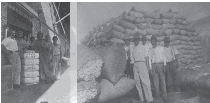
Foto 21 e 22 :Trabalhadores da SANBRA em suas instalações no final da década de 1940. Fonte: Acervo Museu Histórico Municipal “Manoel Francisco de Oliveira”, 1940
