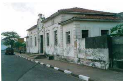
Foto 38: Situação atual da fachada do prédio da estação ferroviária Fonte: CORREIA, A. 2007
