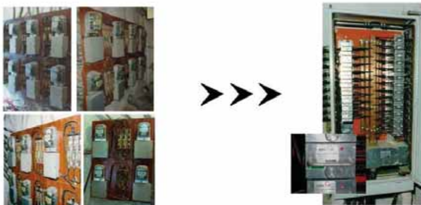
Figura 1 - Modelo de medição centralizada ( http://www.aneel.gov.br/Arquivos/PDF/CEPEL-Landulfo_Mosqueira.pdf )
