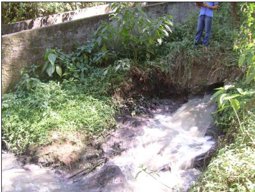
Foto 4: Lançamento de esgoto doméstico no Ribeirão Claro – trecho 5. (05/09/2008)
