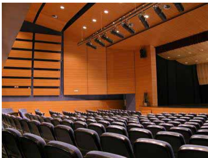
Figura 9: Aplicação de compensados sarrafeados como recurso acústico e estético em um teatro.
