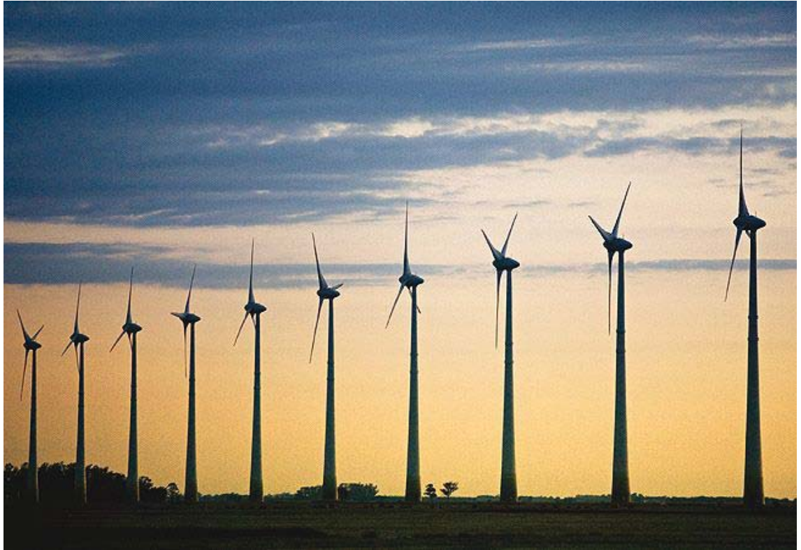
Figura 1.7: Parque eólico em Osório (RS), um dos pioneiros e maiores complexos de energia gerada pelo vento do Brasil, exemplo de parque eólico onshore
