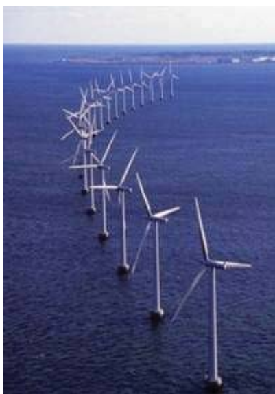
Figura 1.6: Parque eólico offshore de Middelgrunden (Dinamarca) Fonte: http://www.apab.org/fr/page.php?id_rubrique=3&id_sous_rubrique=23
