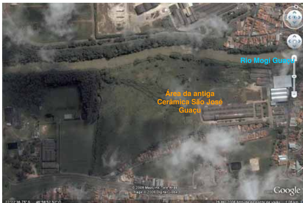
Figura 8 – Área da antiga cerâmica São José Guaçu. Fonte: Google Earth, maio/2009.
