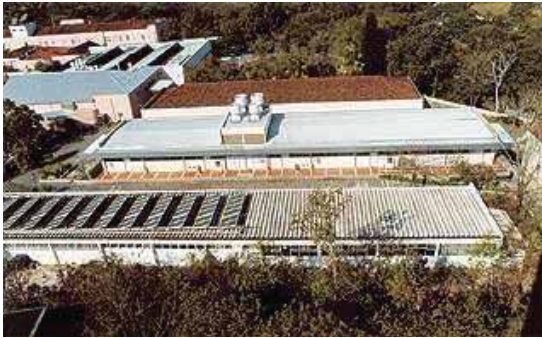
Figura 21: Implantação do novo edifício (ao centro). Acompanha a linearidade dos demais edifícios. Fonte: PROJETO DESIGN. Edição 284, outubro de 2003.
