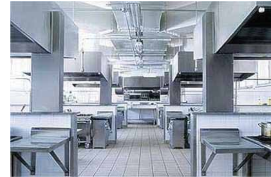
Figura 19: Coifas oferecem exaustão aos laboratórios-cozinha. Fonte: PROJETO DESIGN. Edição 284, outubro de 2003.
