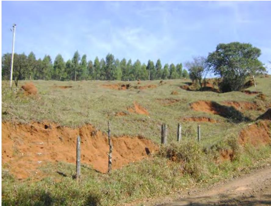
Figura 33 - Conjunto de processos erosivos na Unidade 6 – Diabásio em morrotes alongados.
