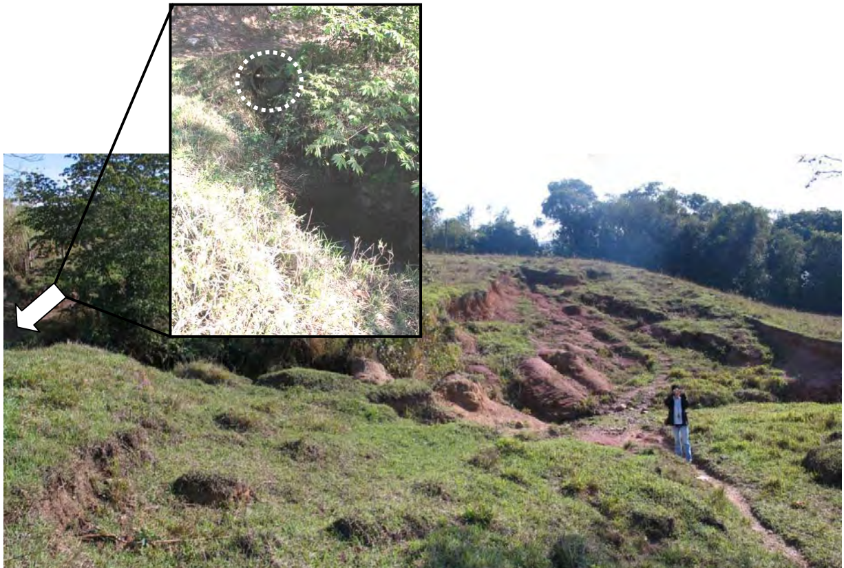
Figura 37 – Evento erosivo perpendicular a beira de estrada, possivelmente originado de um sistema de drenagem na Unidade 10 – Corumbataí em colinas médias. A seta e o círculo pontilhado indicam a localização da galeria ilustrada no detalhe.
