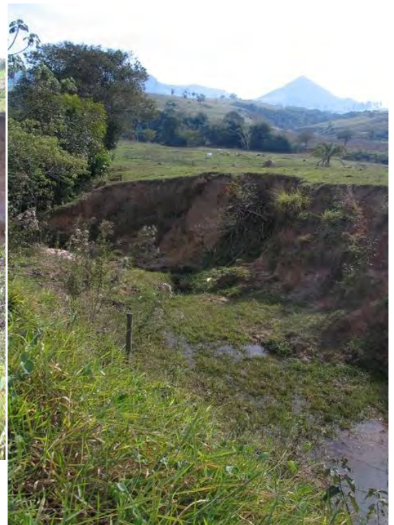
Figura 35 - Vista a jusante.
