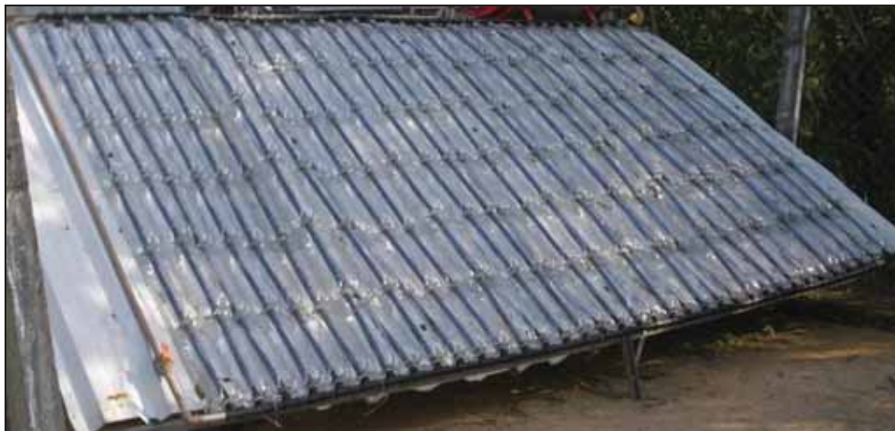
Figura 11 – Coletor solar de garrafa PET do Centro de Energias Renováveis da Faculdade de Engenharia de Guaratinguetá (SANTOS, 2009).
