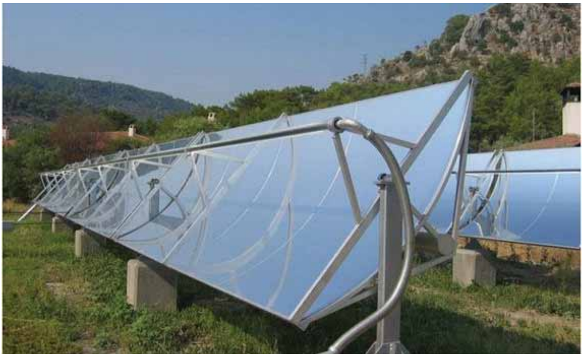
Figura 2 –Concentrador solar tipo cilindro parabólico ( http://anometsolar.com )
