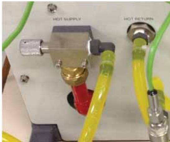
Figura 17 - Válvula de Controle de Vazão do Circuito Quente
