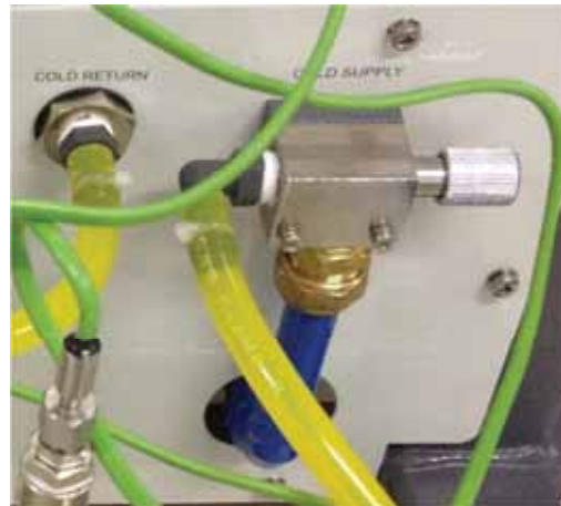
Figura 15 - Válvula de Controle de Vazão do Circuito Frio
