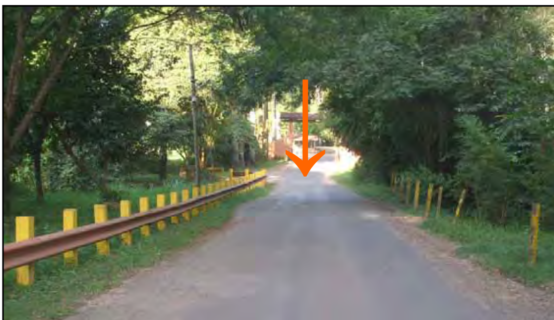
Figura: 15. Ponte do Córrego Lavapés localizada na estrada Operacional, ponto 1 de aplicação dos questionários. . Fotografia: Ricardo Augusto Hardt fevereiro/2009
