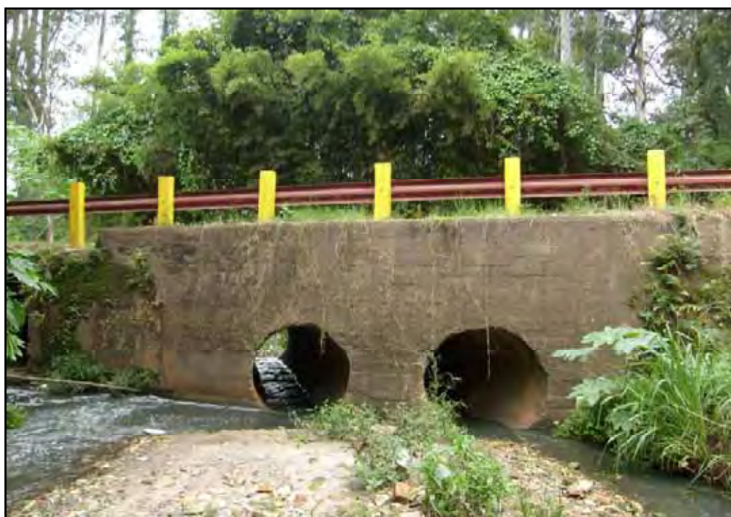
Figura: 12. Vista da estrutura da ponte do Córrego Lavapés. Fotografia: Ricardo Augusto Hardt setembro de 2008.
