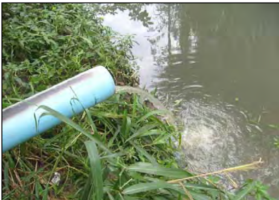
Figura: 5 Ponto de lançamentos de efluentes in natura nas águas do córrego Lavapés, nas proximidades da ponte da estrada operacional. Fotografia: Ricardo Augusto Hardt Agosto/2008.
