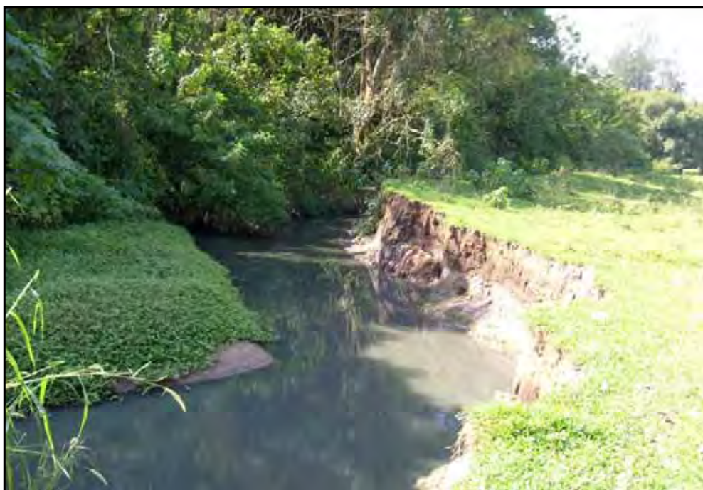
Figura: 9. Exemplo de área à margem dos cursos d'água sem proteção de mata ciliar.
