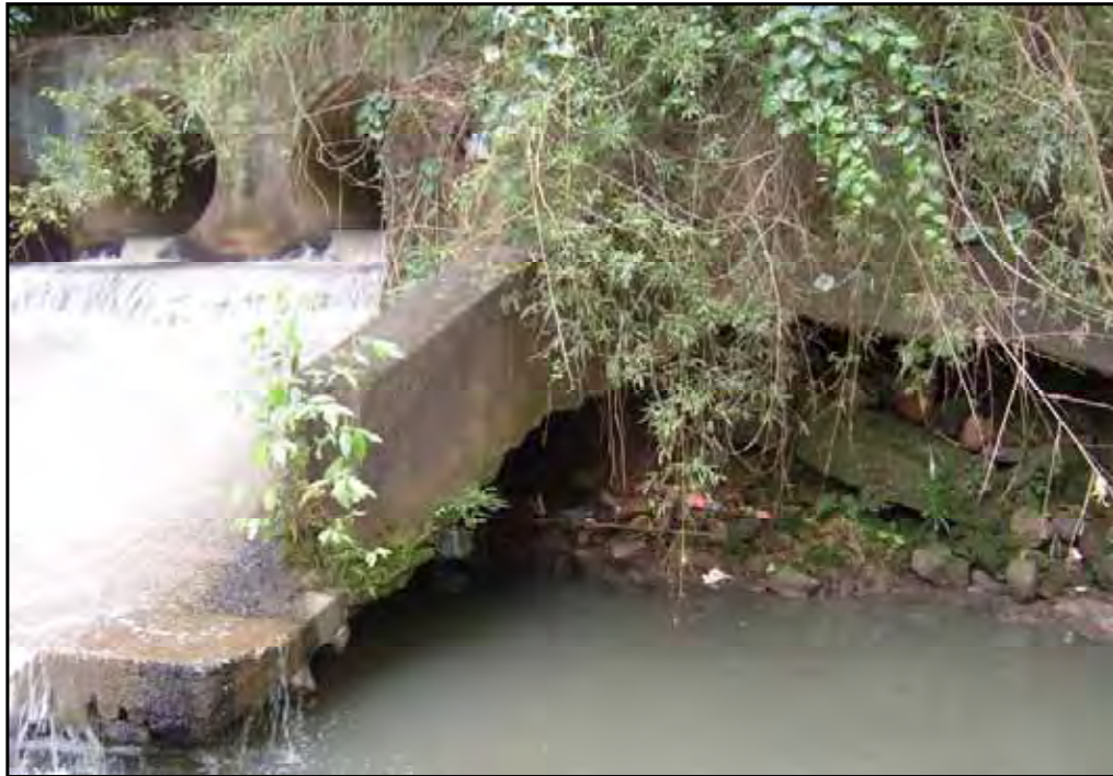
Figura: 13. Processos erosivos danificam a estrutura da ponte do Córrego Lavapés. Fotografia: Ricardo Augusto Hardt setembro/2008.
