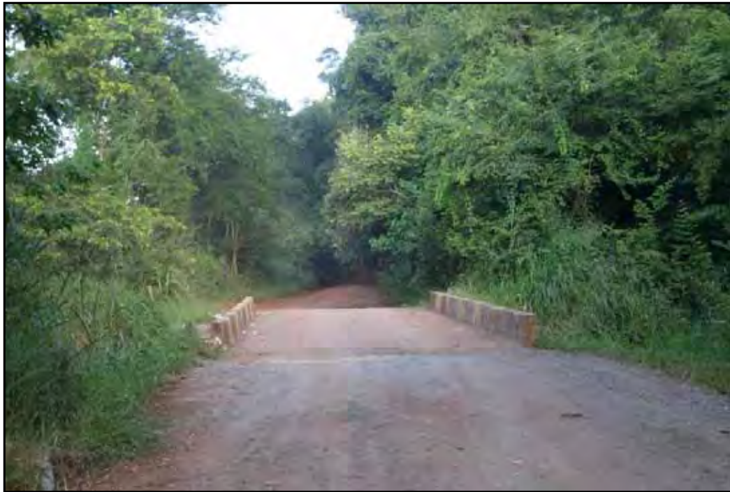
Figura: 17. Ponte do Ribeirão Claro na estrada municipal, ponto 3 de aplicação dos questionários.
