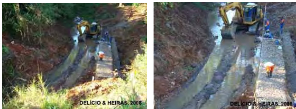
Figura 26 – Obras da SABESP no ribeirão Tanquinho durante o mês de setembro de 2008.
