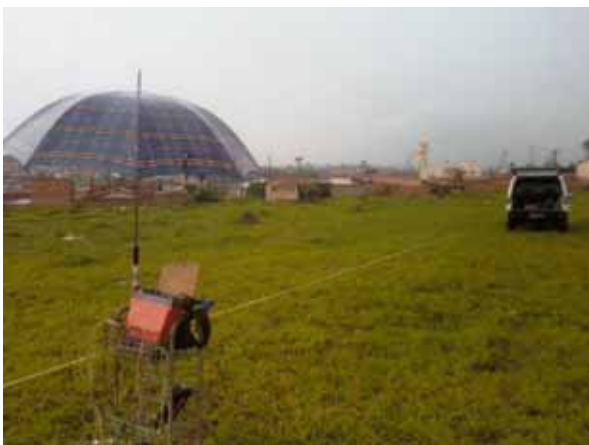
Foto 11 – Execução da Linha Referência 1
