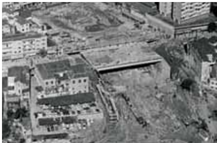
Figura 17 – Viaduto Guilherme de Almeida, Metrô Liberdade e Radial Leste Oeste. (modificado)
