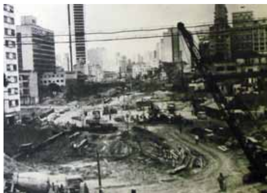
Figura 12 – Avenida da Liberdade, obras do viaduto Jaceguai.
