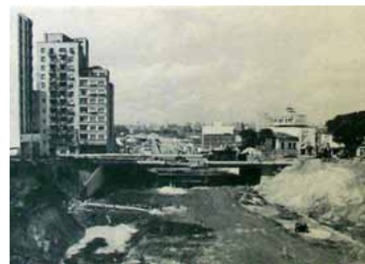
Figura 13 – Rua Conselheiro Furtado, obras da Radial Leste - Oeste, 1972.
