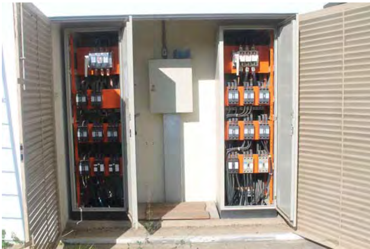
Figura 2 – Painel de baixa tensão do bloco da Física.
