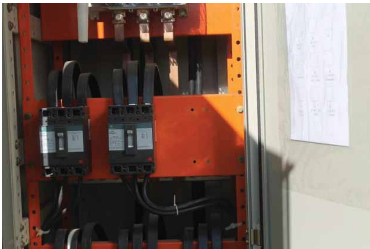
Figura 3 – Ilustração das partes vivas dentro do painel.
