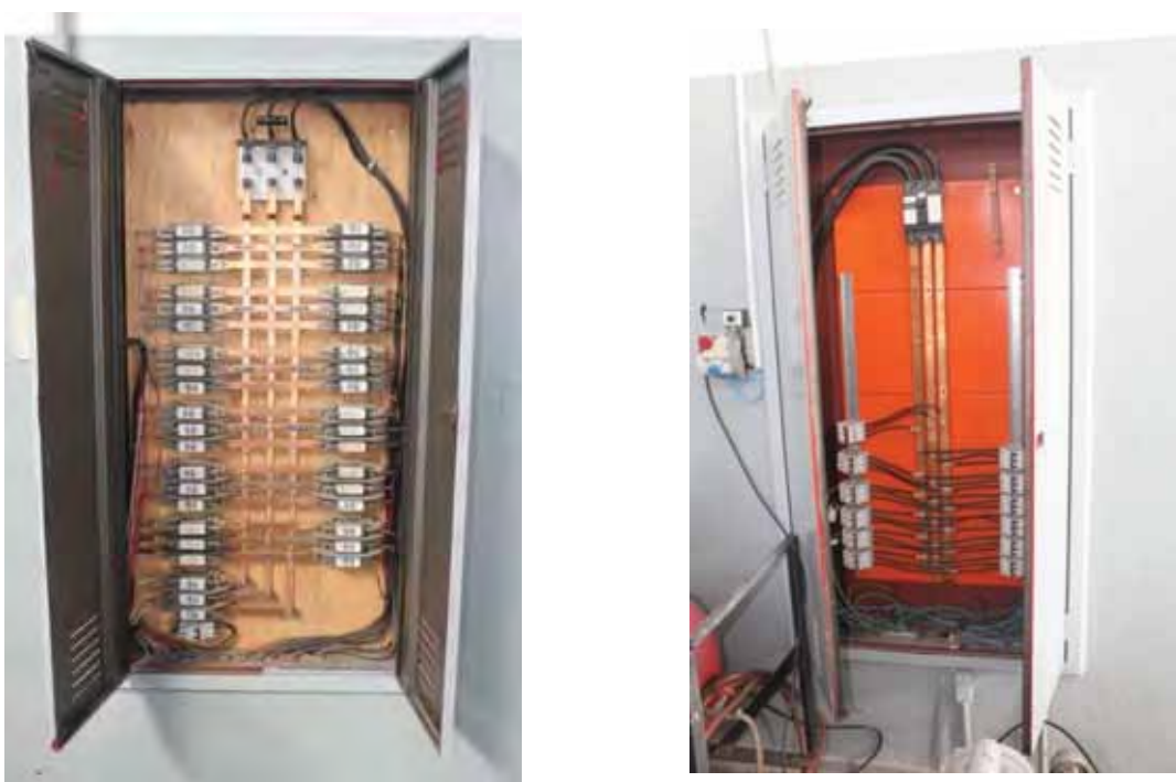
Figura 7 – Painel de baixa tensão do bloco da mecânica do COTEC.
