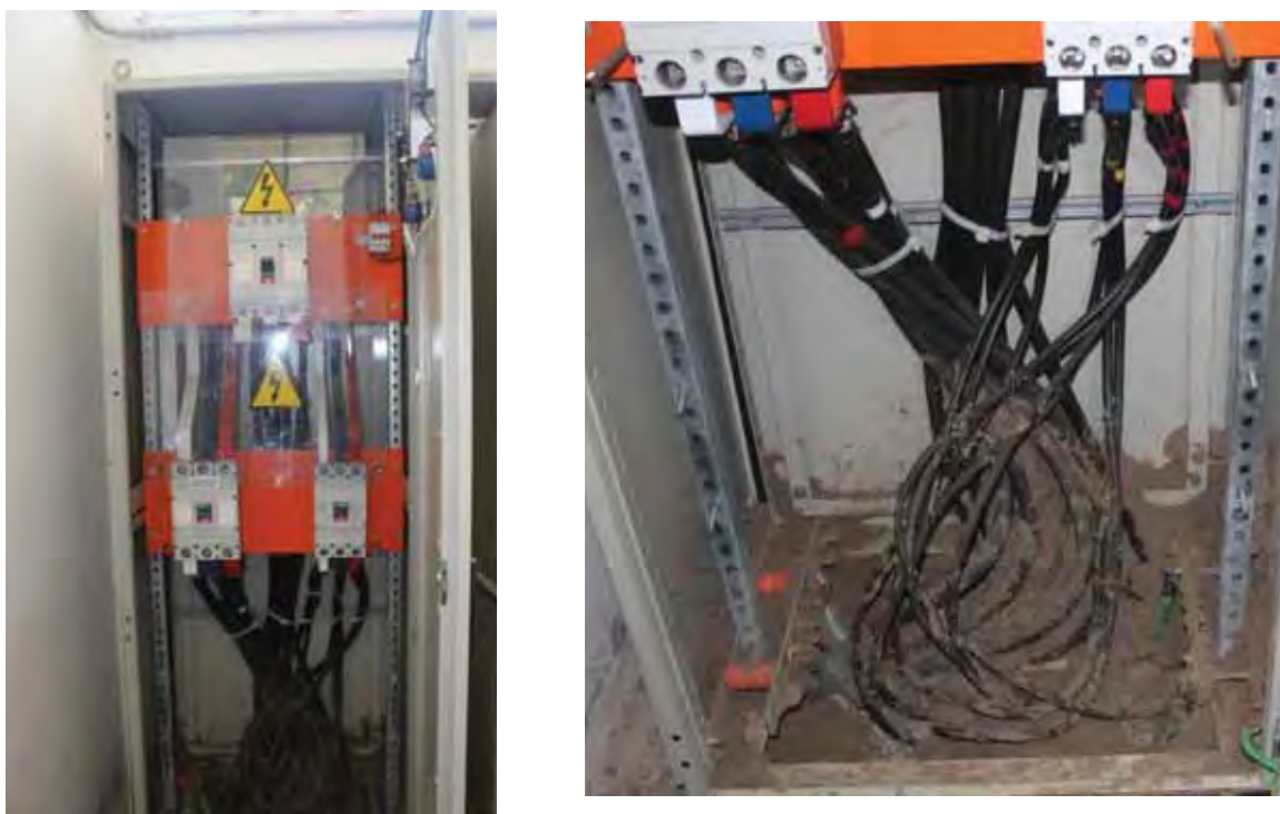
Figura 4 – Painéis de baixa tensão do bloco de Materiais.
