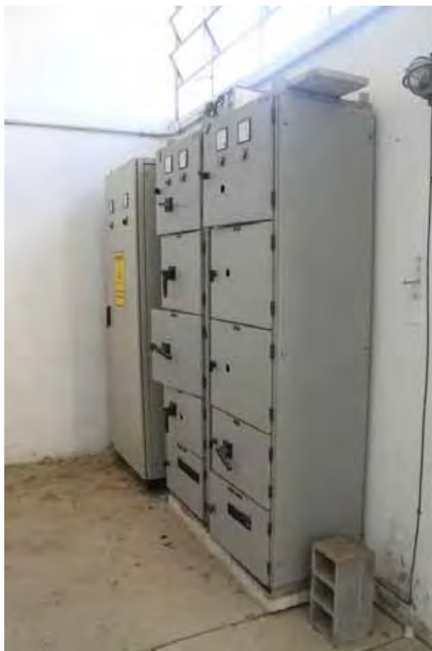
Figura 5 – Painel de baixa tensão do bloco de materiais.
