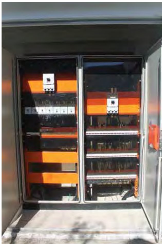
Figura 8 – Painel de baixa tensão do bloco da Física.
