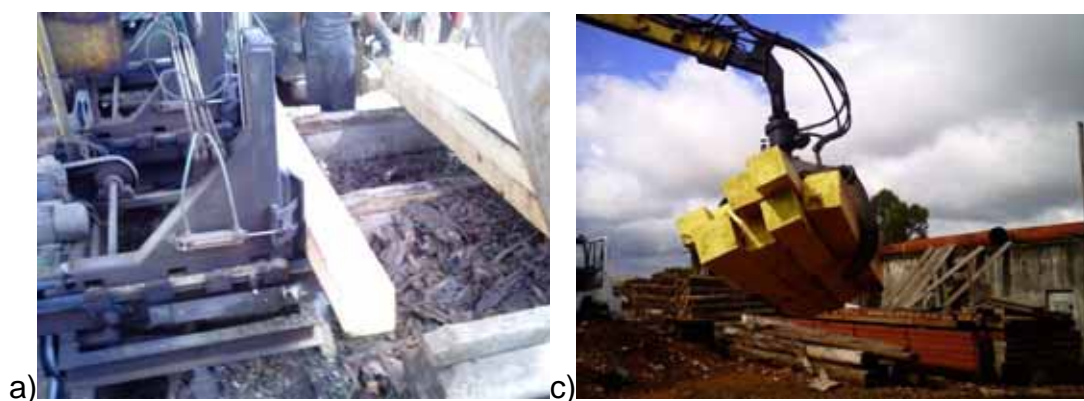
Figura 9- Corte e transporte dos blocos. a) Corte da tora para confecção do bloco; c) Movimentação dos blocos com auxílio da grua.
