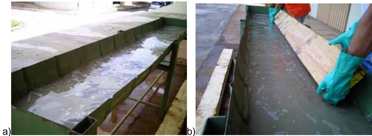
Figura 10- Tratamento dos pranchões: a) Tanque com Osmotox Plus ; b) Pranchões recebendo tratamento.
