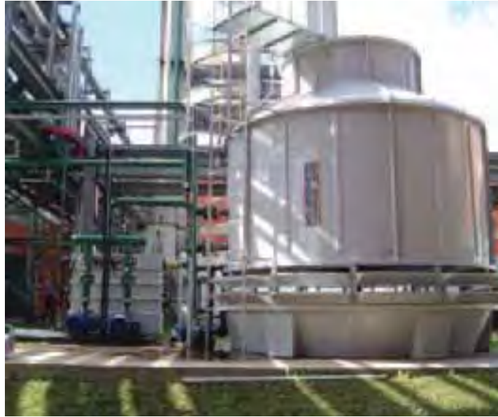
Figura 36 – Imagem da torre de resfriamento considerada no estudo.
