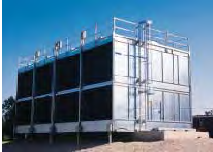
Figura 28: Foto de uma torre de resfriamento de circulação mecânica induzida
