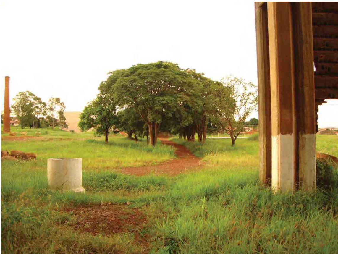
Figura 27. A alameda arborizada entre o Teatro Municipal e as estruturas do antigo forno. Ao lado esquerdo, a chaminé (Foto do autor, 2011)
