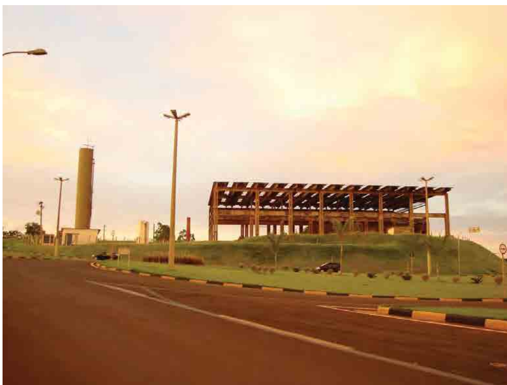
Figura 30 .A força da imagem da estrutura, percorrendo-se as ruas ao redor. (Foto do autor, 2011)
