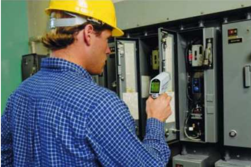
Figura 13 – Inspeção termográfica em um quadro elétrico.
