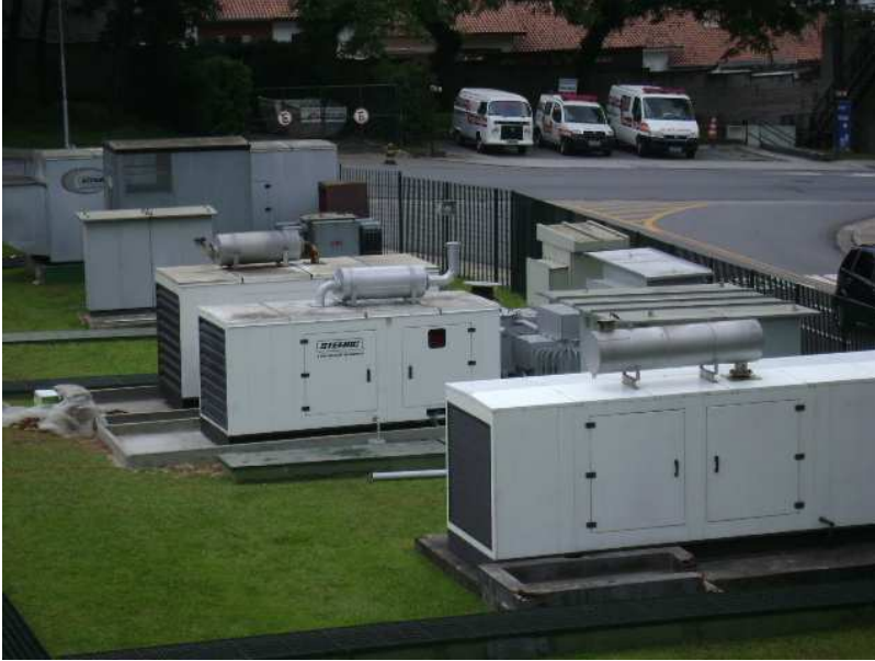
Fotografia 1 – Pátio de geradores.
