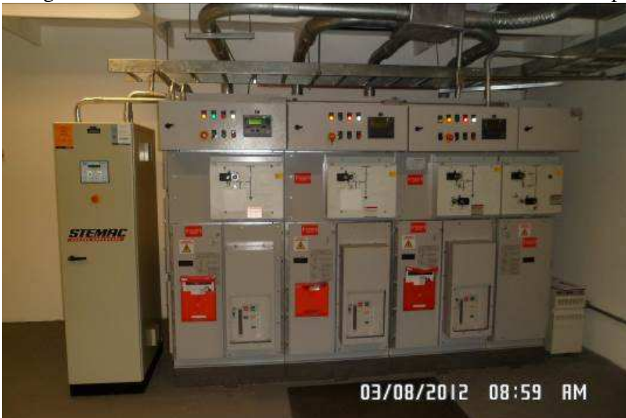
Fotografia 2 – Painel elétrico de média tensão na sala de elétrica do primeiro andar, bloco A.
