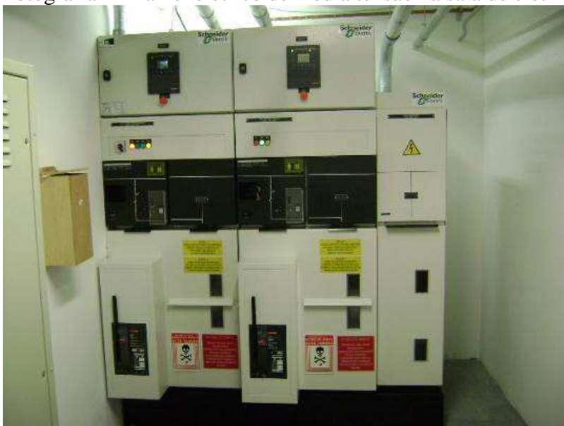
Fotografia 4 - Painel elétrico de média tensão na sala de elétrica do sexto andar, bloco E.
