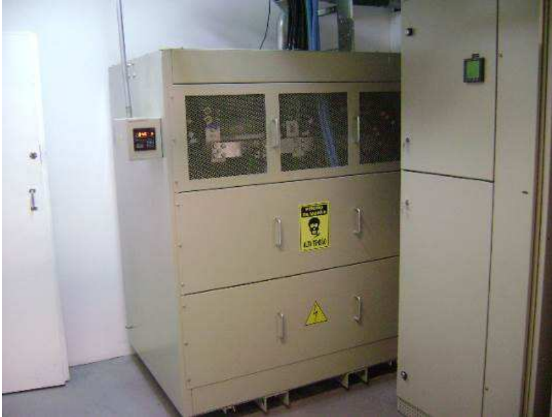
Fotografia 5 - Transformador seco de potência na sala de elétrica do sexto andar, bloco E.
