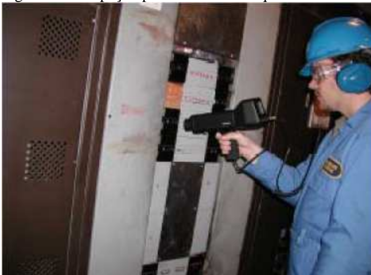
Figura 15 – Inspeção por ultrassom em quadro elétrico.
