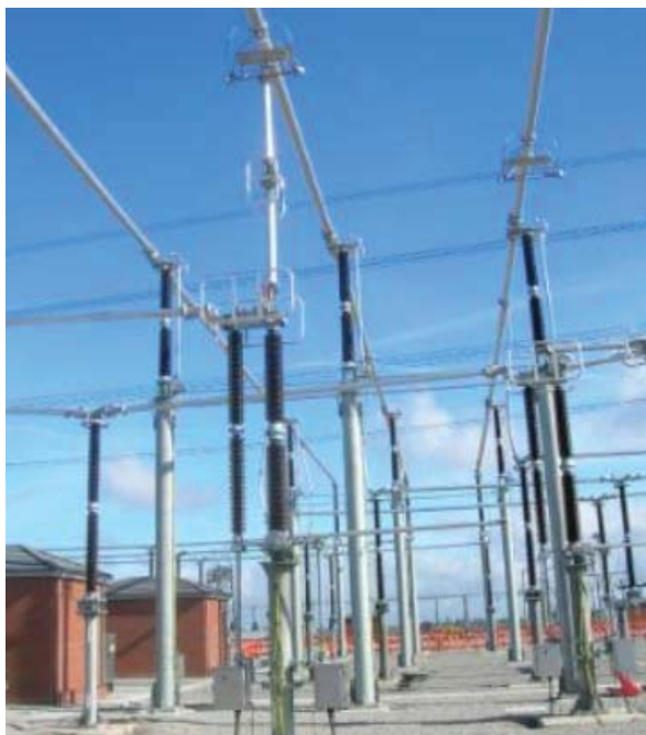
Figura 34 – Disjuntor AT, modelo GL, fabricante Alstom (Cortesia da Alstom)
