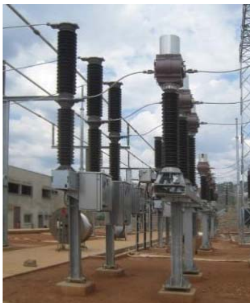
Figura 33 – Disjuntor AT, modelo GL, fabricante Alstom (Cortesia da Alstom)
