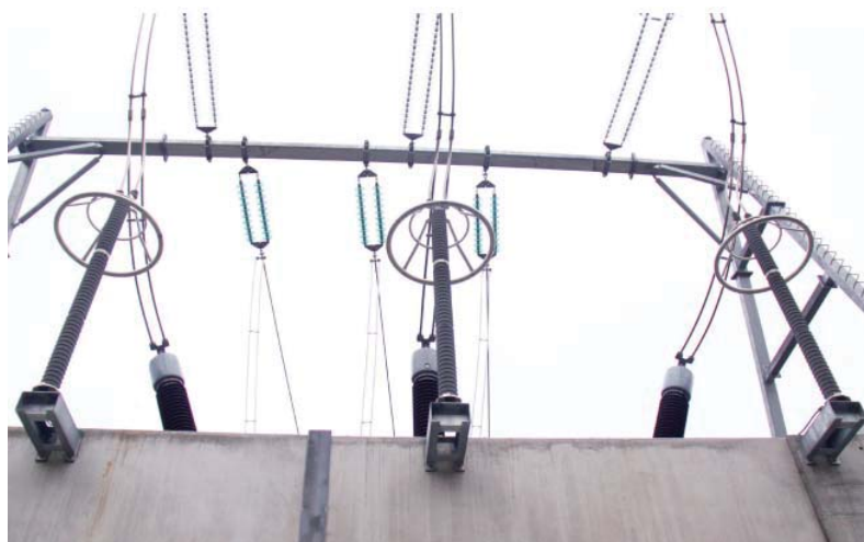
Figura 36– Para raio da fornecedora ABB (Cortesia da ABB)
