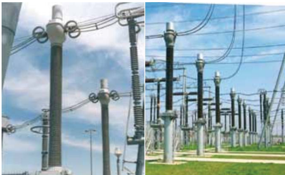
Figura 35– TC de AT, modelo OSKF, fabricante Alstom (Cortesia da Alstom).
