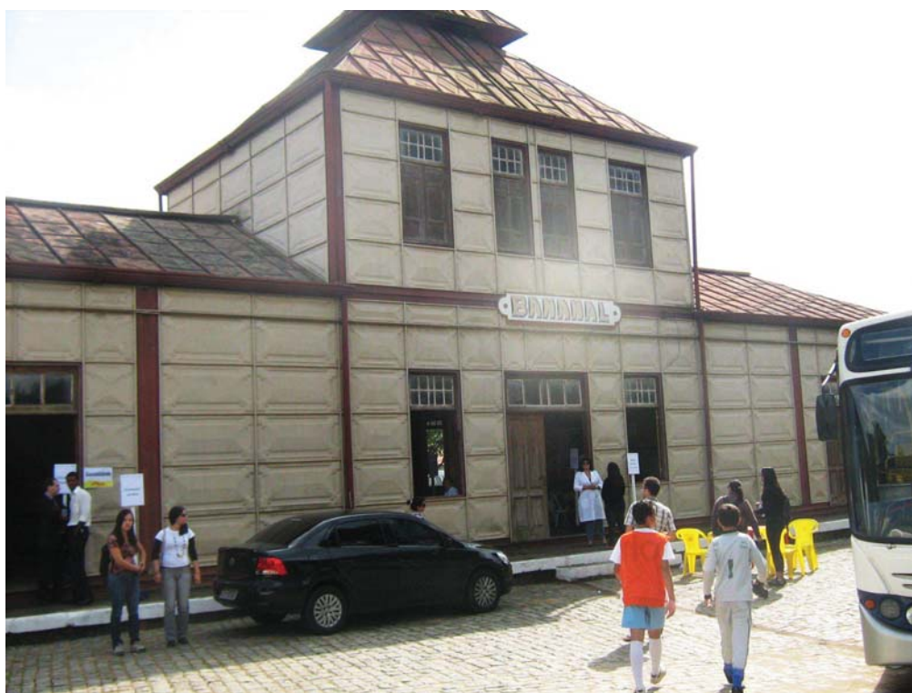
Figura 17: Antiga estação ferroviária de Bananal oriunda da Bélgica. Foto do autor.
