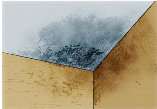
Figura 18 – Exemplo de condensação (fonte: site C&C).
