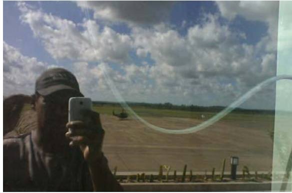
Figura 61 – Aplicação incorreta da vedação em esquadria de alumínio (fonte: Arquivos da construtora X).
