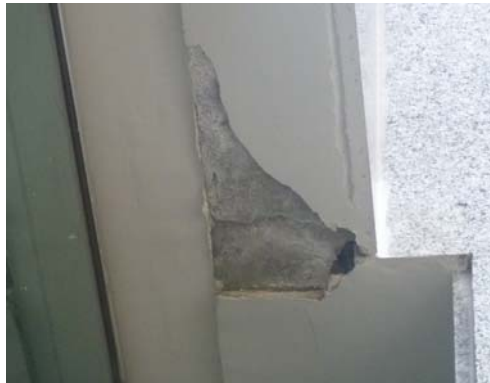
Figura 70 – Deficiência na aplicação da massa única (fonte: Arquivos da construtora X).
