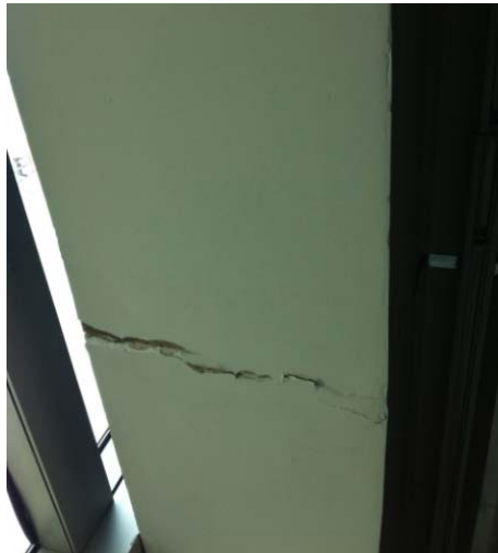
Figura 34 - Fissuras em paredes com aberturas por deformação da estrutura (fonte: Arquivos da construtora X).
