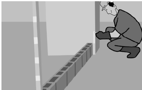
Figura 48 – Exemplo de utilização de escantilhão para a execução do plano de alvenaria e a marcação das alturas do fio-cabelo a cada 40 cm (fonte: retirado de documento da construtora X).
