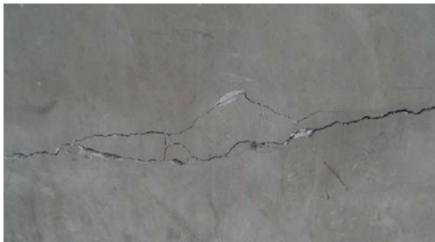
Figura 39 - Fissuras horizontais por sobrecargas (fonte: Arquivos da construtora X).
