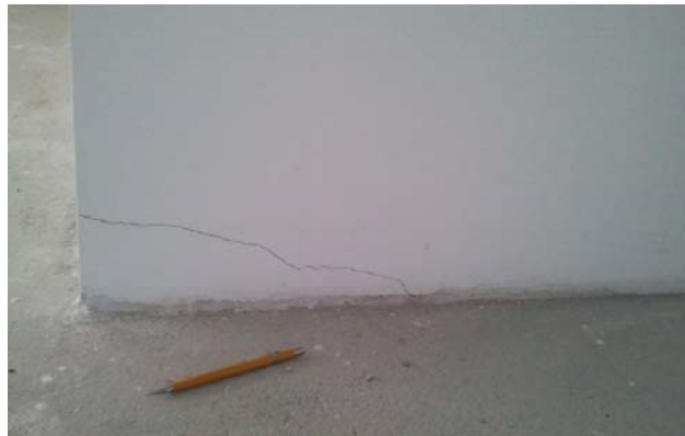
Figura 42 - Fissuras inclinadas em paredes transversais por movimentação térmica da laje (fonte: Arquivos da construtora X).
