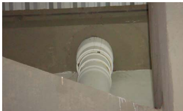
Figura 51 – Deficiência na realização da impermeabilização por manta asfáltica em ralos (fonte: Arquivos da construtora X).
