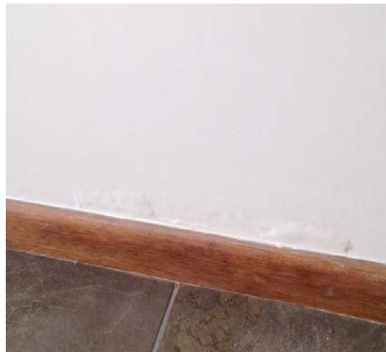
Figura 58 – Deficiência na impermeabilização da viga baldrame apresentando umidade no rodapé dos muros internos (fonte: Arquivos da construtora X).
