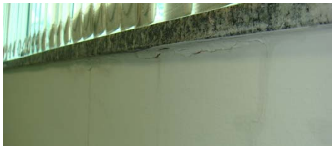
Figura 62 – Instalação incorreta da vedação e contramarco em esquadria de alumínio (fonte: Arquivos da construtora X).
