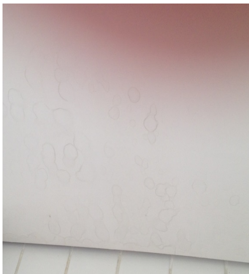
Figura 56 – Falha na aplicação da impermeabilização por emulsão asfáltica no piso superior (fonte: Arquivos da construtora X).
