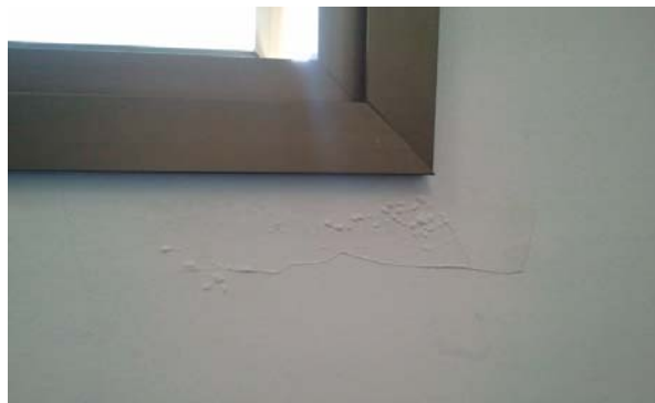
Figura 65 – Instalação incorreta da vedação e contramarco em esquadria de alumínio (fonte: Arquivos da construtora X).
