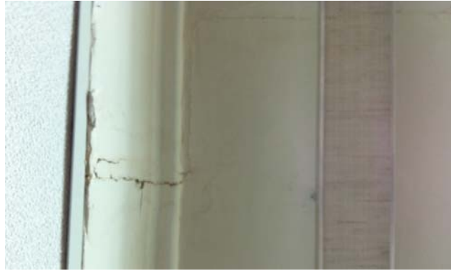
Figura 35 - Fissuras em paredes com aberturas por deformação da estrutura (fonte: Arquivos da construtora X).
