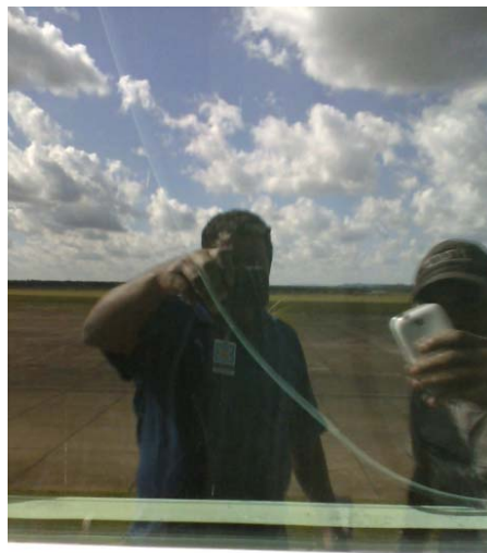
Figura 60 – Aplicação incorreta da vedação em esquadria de alumínio (fonte: Arquivos da construtora X).
