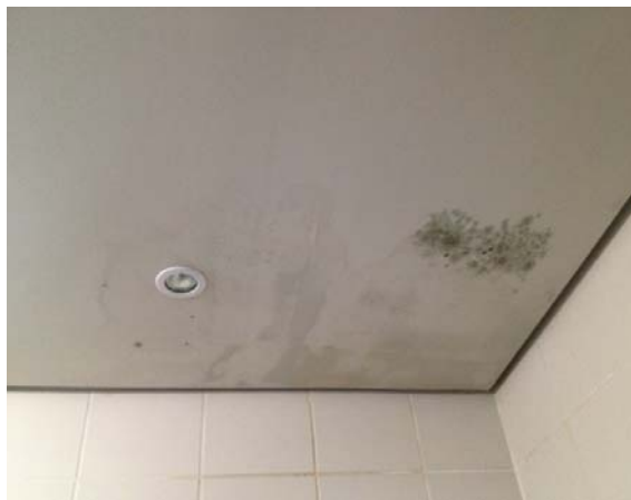
Figura 55 – Falha na aplicação da impermeabilização por emulsão asfáltica no piso superior (fonte: Arquivos da construtora X).
