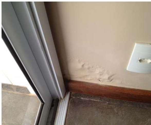
Figura 59 – Deficiência na impermeabilização da viga baldrame apresentando umidade no rodapé dos muros internos (fonte: Arquivos da construtora X).
