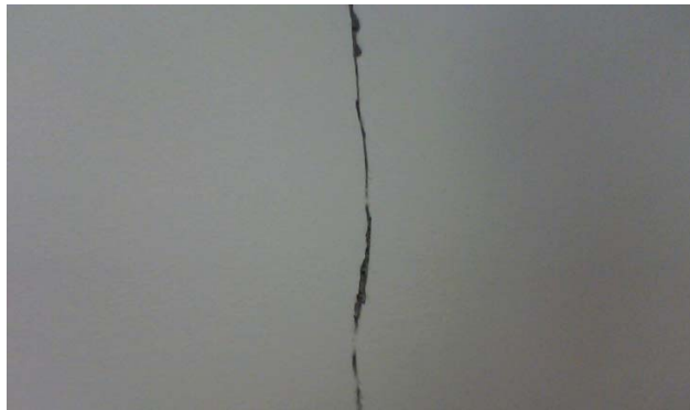
Figura 36 - Fissuras verticais em paredes por retração da alvenaria (fonte: Arquivos da construtora X).
