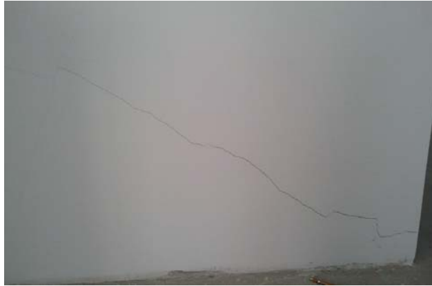
Figura 41 - Fissuras inclinadas em paredes transversais por movimentação térmica da laje (fonte: Arquivos da construtora X).
