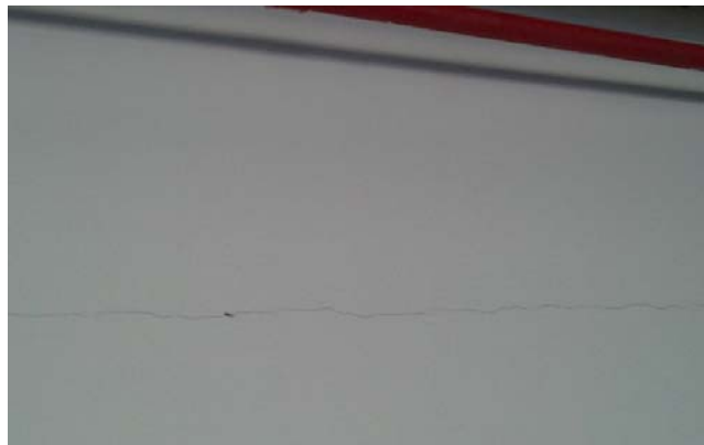
Figura 43 - Fissuras horizontais por movimentação térmica da laje (fonte: Arquivos da construtora X).
