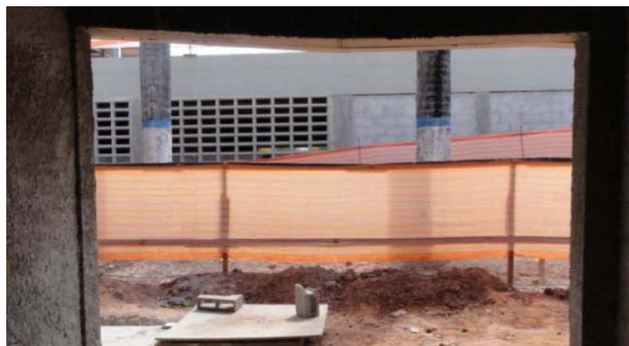
Figura 46 - Desalinhamento da viga superior em vão realizado na parede de alvenaria (fonte: Arquivos da construtora X).
