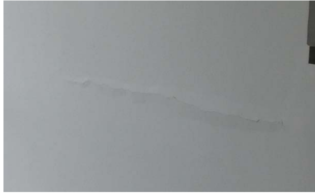
Figura 38 - Fissuras horizontais por sobrecargas (fonte: Arquivos da construtora X).
