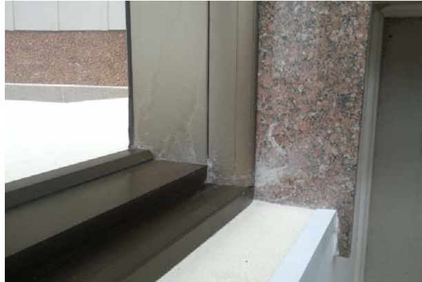
Figura 67 – Aplicação incorreta da vedação em esquadria de alumínio (fonte: Arquivos da construtora X).
