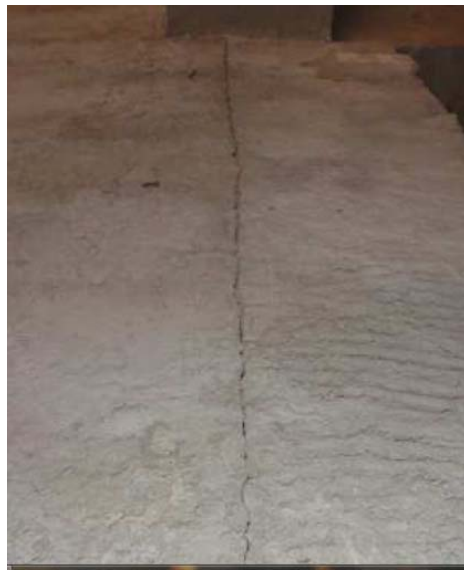
Figura 45 - Trinca ocasionada pela falta de argamassa entre alvenaria e estrutura de concreto, espessura mínima=1cm (fonte: Arquivos da construtora X).
