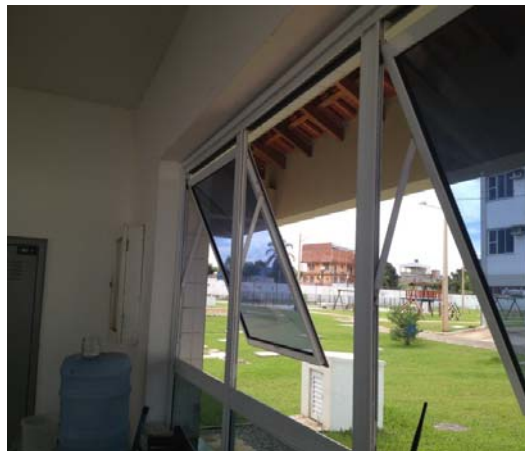
Figura 63 – Instalação incorreta do contramarco em esquadria de alumínio (fonte: Arquivos da construtora X).
