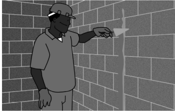
Figura 71 – Exemplo da execução da faixa de mestra na parede de alvenaria (fonte: retirado de documento da construtora X).
