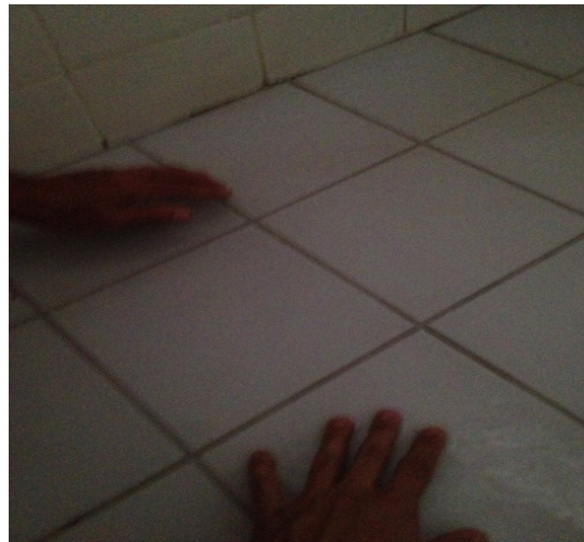
Figura 74 – Deficiência na aplicação de piso cerâmico, piso descolando (fonte: Arquivos da construtora X).
