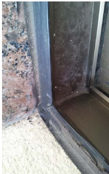
Figura 66 – Aplicação incorreta da vedação em esquadria de alumínio (fonte: Arquivos da construtora X).
