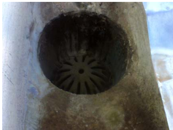
Figura 50 – Deficiência na realização da impermeabilização por manta asfáltica em ralos (fonte: Arquivos da construtora X).
