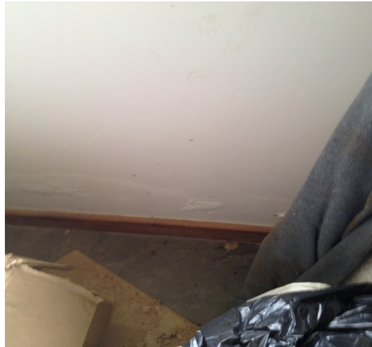
Figura 57 – Deficiência na impermeabilização da viga baldrame apresentando umidade no rodapé dos muros internos (fonte: Arquivos da construtora X).
