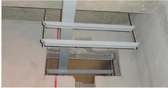
Figura 44 – Ausência de verga e contra-verga no vão da alvenaria para passagem de instalações elétricas (fonte: Arquivos da construtora X).
