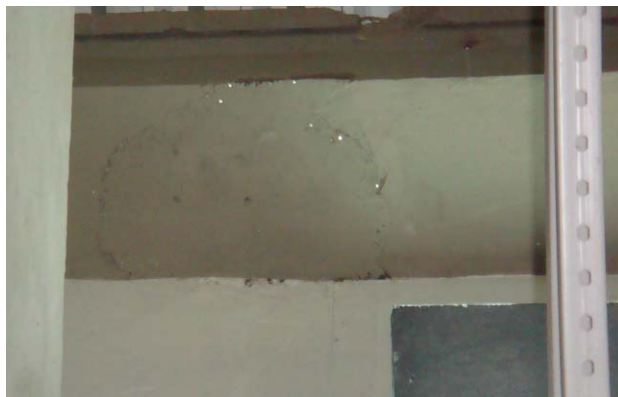
Figura 52 – Deficiência na realização da impermeabilização por manta asfáltica em ralos (fonte: Arquivos da construtora X).
