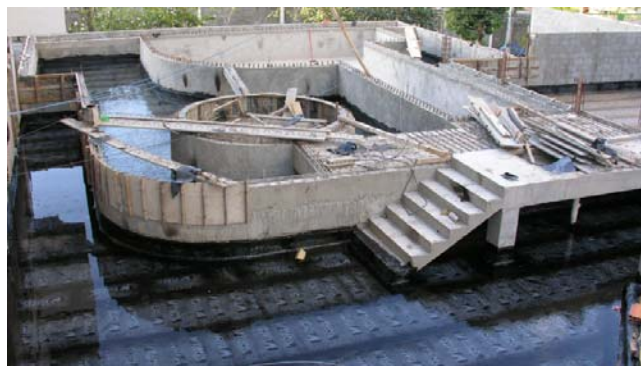
Figura 53 – Exemplo de teste de estanqueidade realizada em impermeabilizações por manta asfáltica (fonte: Arquivos da construtora X).
