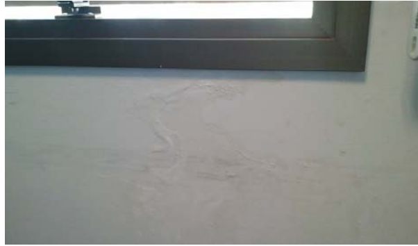
Figura 64 – Instalação incorreta da vedação e contramarco em esquadria de alumínio (fonte: Arquivos da construtora X).
