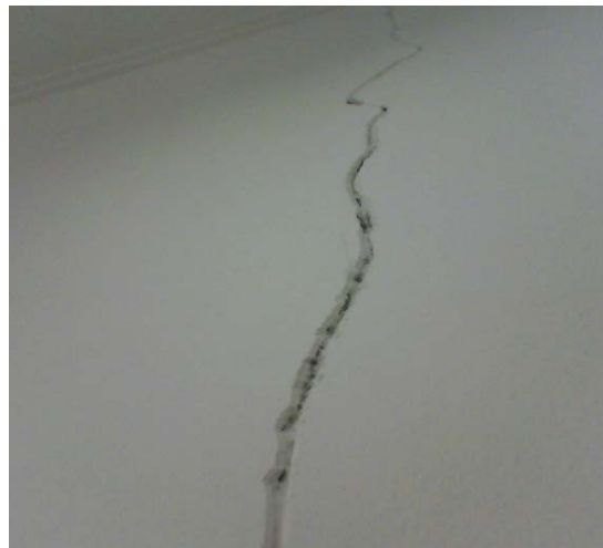
Figura 37 - Fissuras verticais em paredes por retração da alvenaria (fonte: Arquivos da construtora X).
