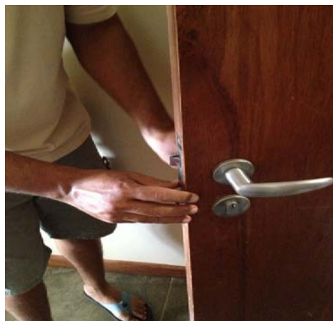
Figura 69 – Porta de madeira com problema de prumo (fonte: Arquivos da construtora X).
