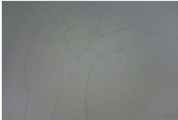
Figura 73 – Falha no procedimento de execução do gesso, não molhou a superfície antes da aplicação (fonte: Arquivos da construtora X).
