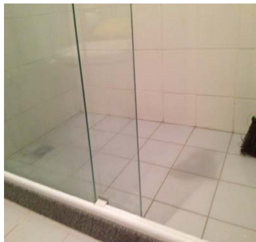
Figura 75 – Deficiência na aplicação do rejunte em revestimento cerâmico (fonte: Arquivos da construtora X).
