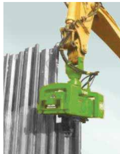
Figura 44: Implantação de estaca prancha por prensagem. Tecnologia de muro de arrimo que permite construção próxima a edifícios existentes sem prejudicar as estruturas.
