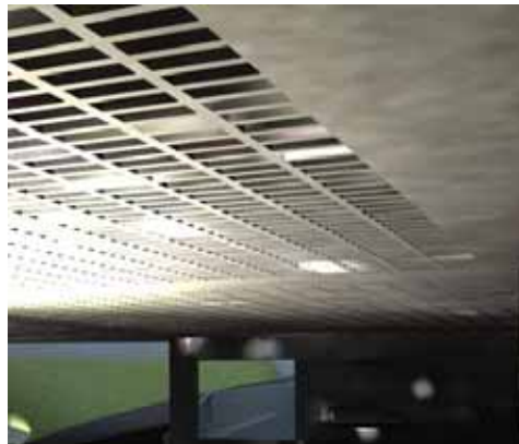
Figura 47: No detalhe, a junção entre a laje nervurada e a viga-faixa.
