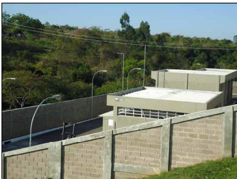
Foto 5 – Estação Elevatória de Esgoto 1 Zona Leste da cidade de Presidente Prudente Fonte: Trabalho de Campo 2010
