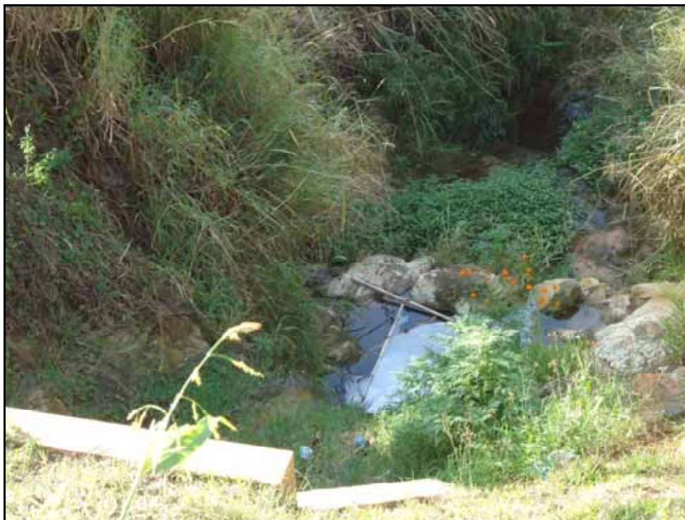
Foto 7 - Deposição de lixo no Córrego do Gramado, saída de água da Galeria Pluvial Próximo a Estação Elevatória de Esgoto 1 Fonte: Trabalho de Campo 2010
