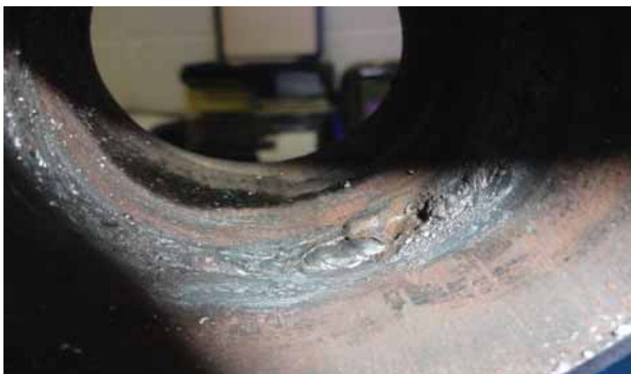
Figura 22- Detalhe do passe de raiz interna ao tubo
