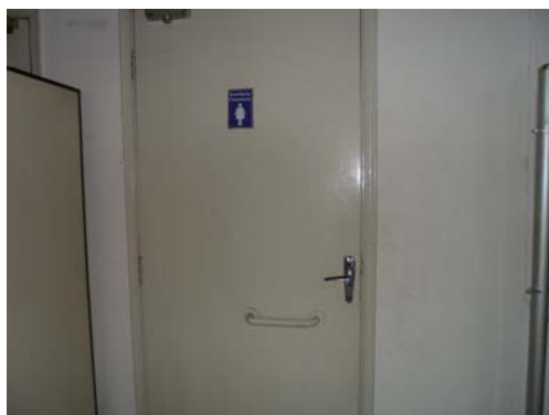
Figura 3.5 - Ausência do símbolo de acessibilidade Fonte: Arquivo do(a) autor(a)
