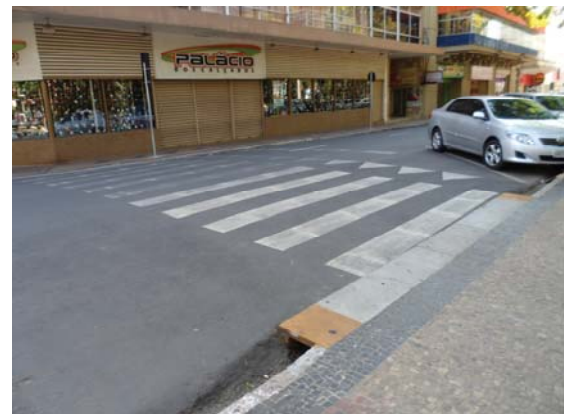
Figura 4.2 – Faixa elevada, cruzamento da rua 4 com av. 1 Fonte: Arquivo do(a) autor(a)
