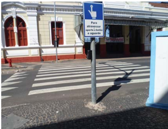
Figura 4.3 – Faixa elevada, cruzamento da rua 1 com av. 2. Fonte: Arquivo do(a) autor(a)
