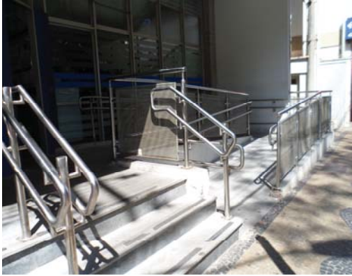
Figura 2.1- Corrimões na rampa e escada Fonte: Arquivo do(a) autor(a)
