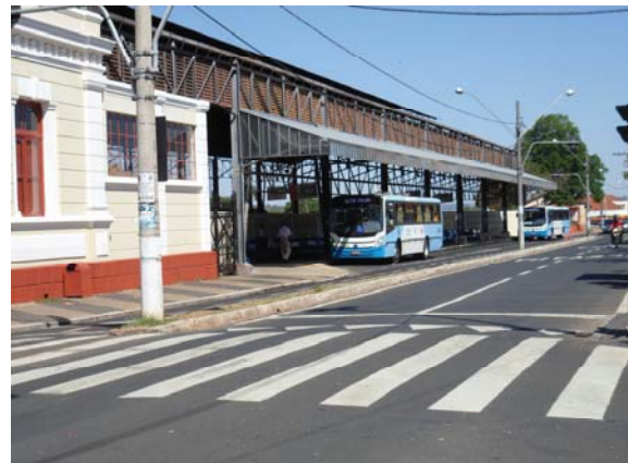
Figura 4.4 - Faixa elevada para acessar o terminal de ônibus Fonte: Arquivo do(a) autor(a)
