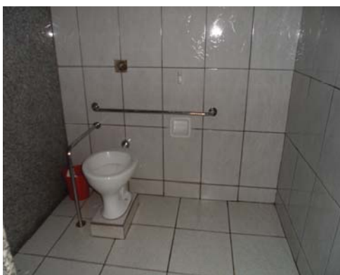
Figura 1.10 - Vaso sanitário com barras de apoio.
