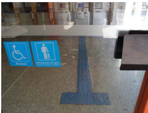
Figura 2.4 - Piso tátil e símbolos de acessibilidade
