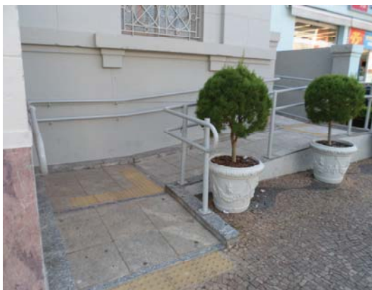
Figura 2.14 – Entrada lateral para deficiente físico Fonte: Arquivo do(a) autor(a)
