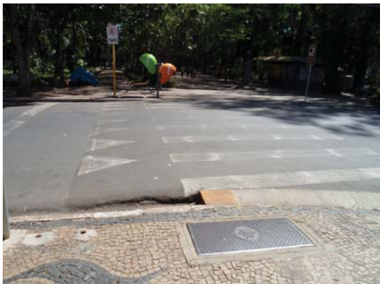
Figura 4.1 – Faixa elevada, cruzamento da rua 3 com av. 1 Fonte: Arquivo do(a) autor(a)
