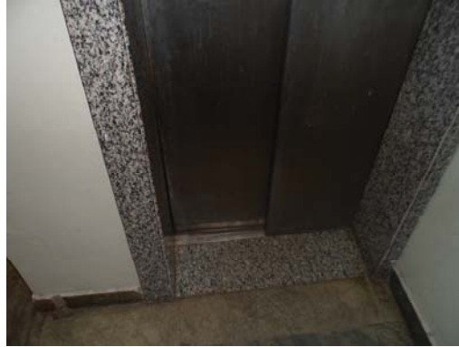
Figura 3.6 - Ausência de piso tátil Fonte: Arquivo do(a) autor(a)
