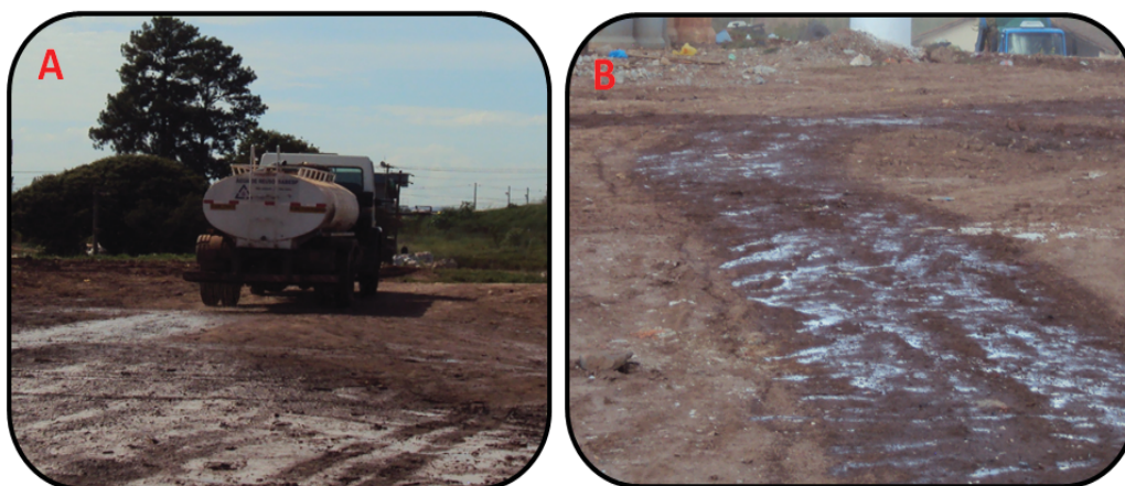
Figura 8: Caminhão tanque realizando a recirculação do lixiviado na superfície do aterro e o solo encharcado logo após a prática.
