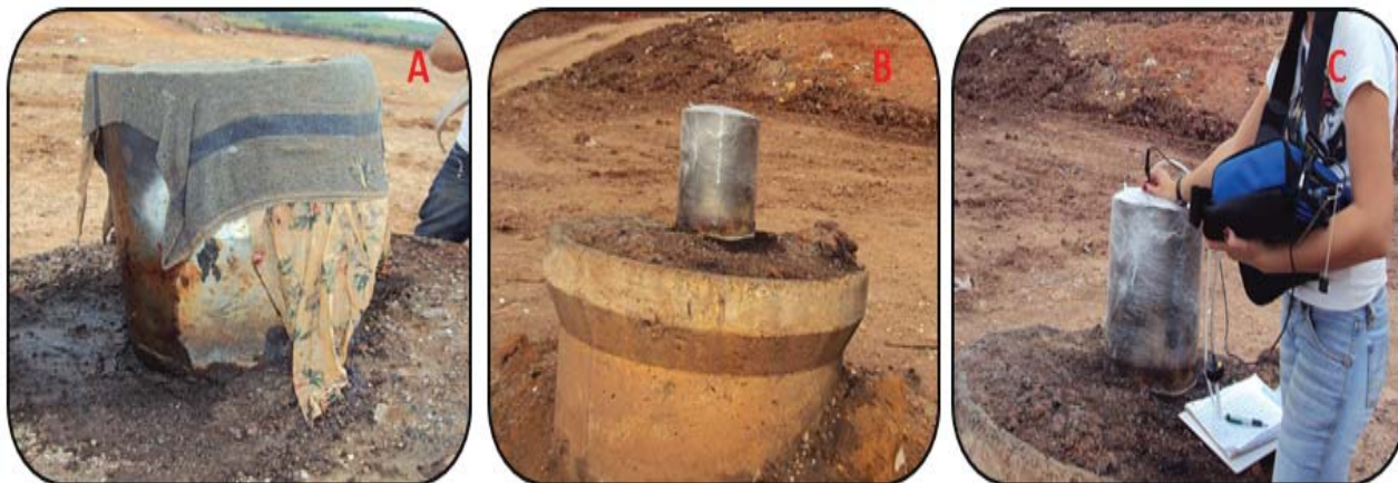
Figura 15: A – Apagando o fogo dos drenos com panos molhados; B- selamento do dreno com plástico filme; C – Medição da concentração do biogás com o equipamento LANDTEC GEM-2000.
