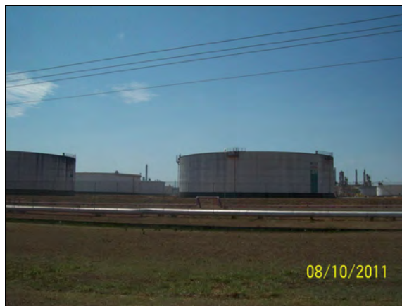
Figura 6: Vista da Refinaria do Planalto Paulista – REPLAN.
