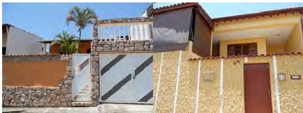
Figura 12 - Casas que foram reformadas
