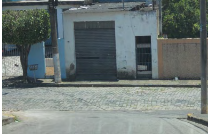
Figura 16 - A rua asfaltada pertence ao bairro Nova Guar e a rua de paraleleppedos ao IAPI.
