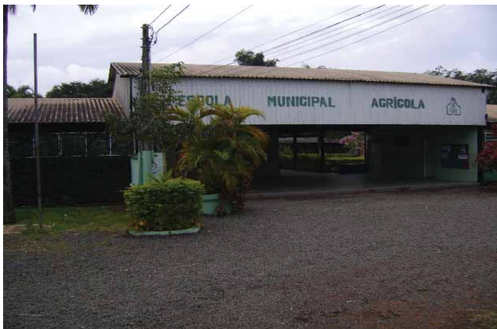
Figura 4 - Pátio principal da Escola Agrícola, onde convergem as salas de aula e o refeitório.
