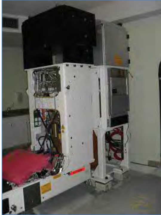
Figura 5: Acelerador linear em processo de instalação. Fonte: do autor.
