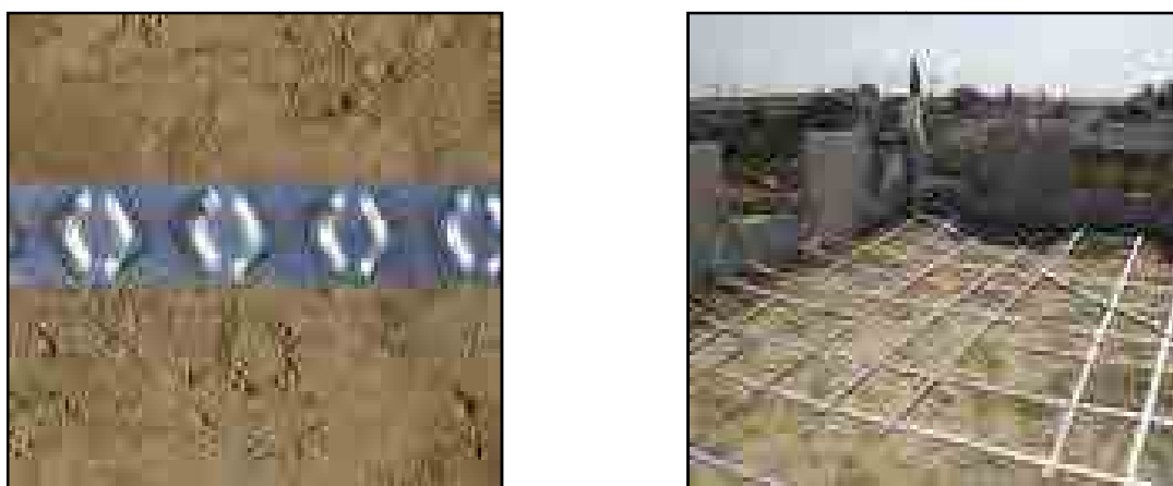
Figura 2.12 – Reforço em geossintético para estruturas em terra armada (Mota, 2010).
