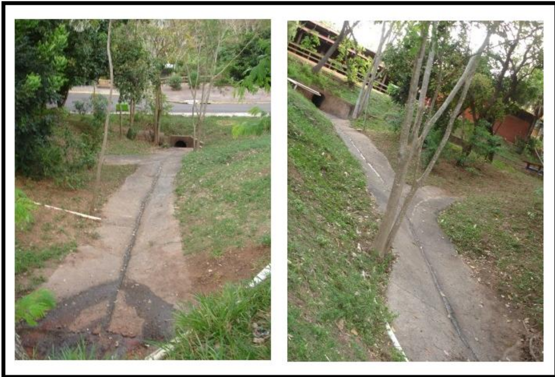
Figura 11: Tubulações e canaletas. Fonte: Nagao; Vicentin (2012).
