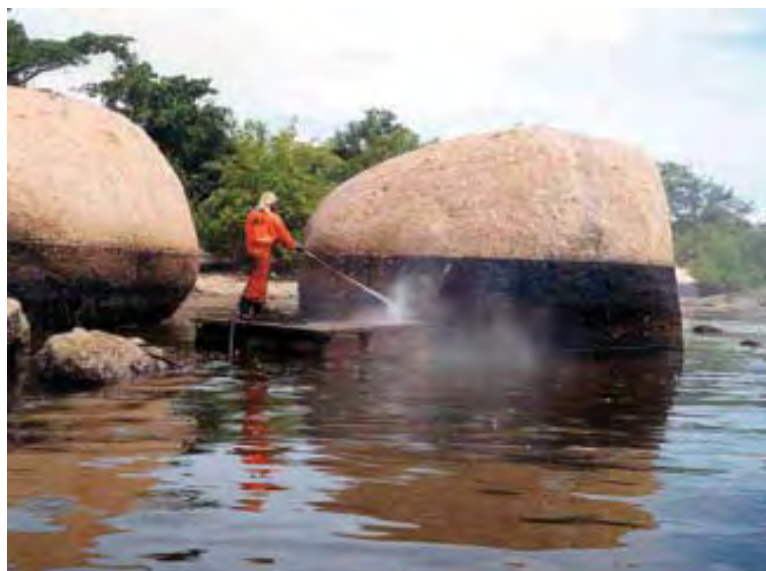
Figura 26 – Jateamento de costão rochoso sendo executado.
