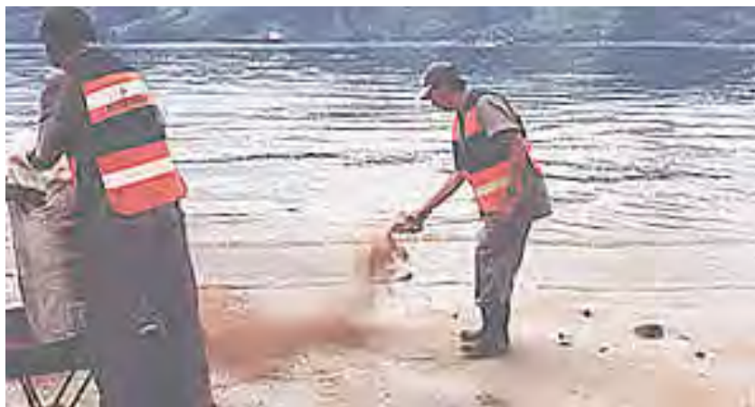
Figura 25 – Funcionários aplicando absorventes granulados na praia.
