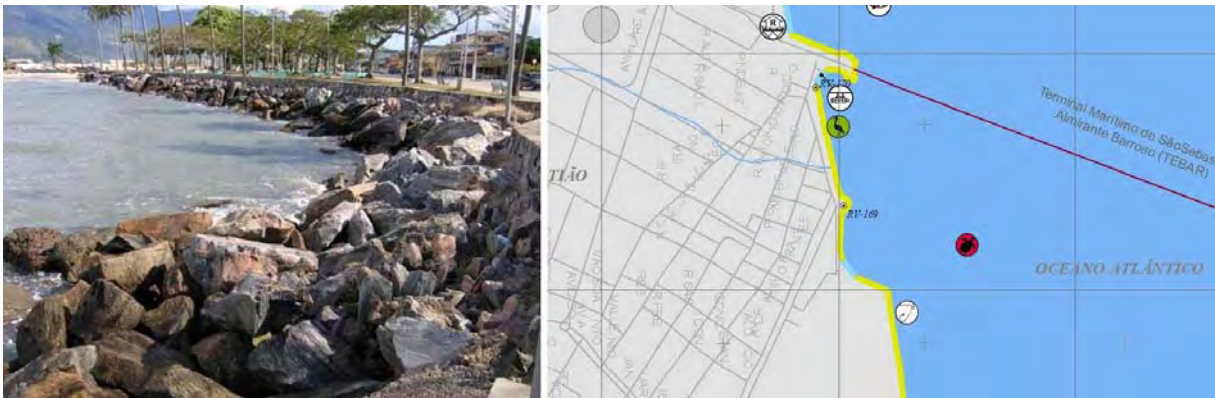
Figura 36: Enrocamento heterogêneo e esquematização na carta SAO (em amarelo, as estruturas artificiais).
