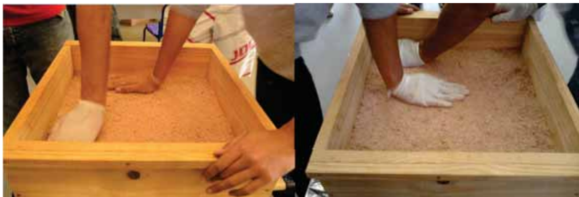
Figura 12 - Pré-prensagem do colchão para acomodação dos materiais em camadas.
