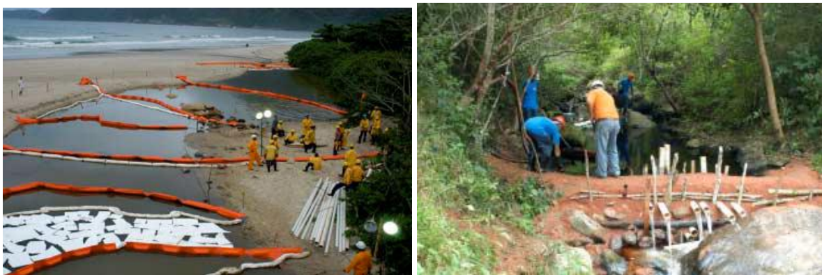
Figura 12 - Barreiras de contenção e barragens no rio Guaecá, respectivamente. Fonte: CETESB (2005)
