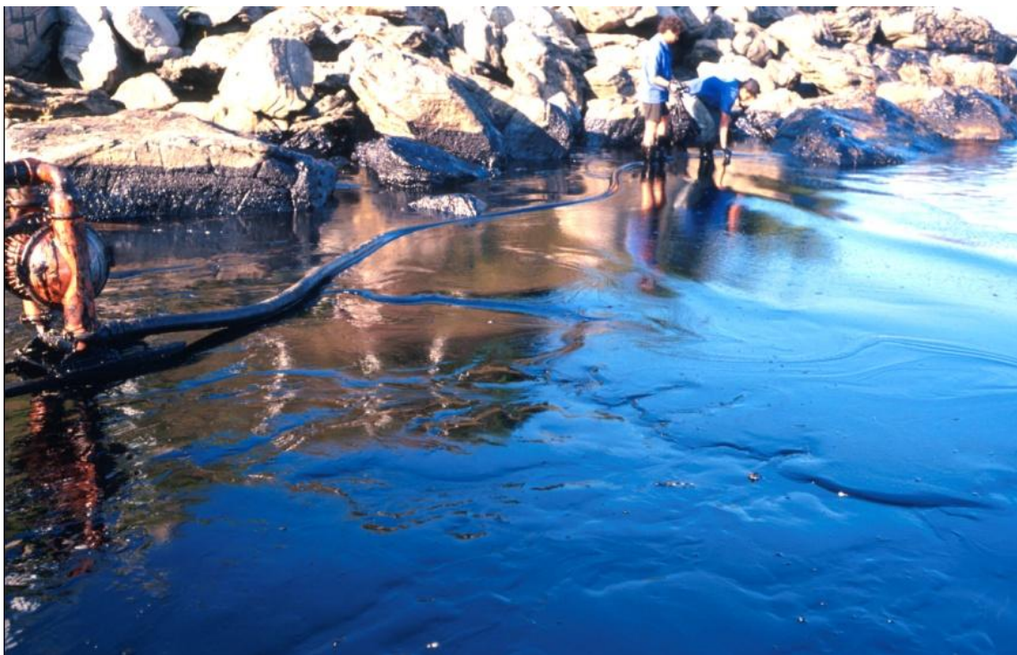
Figura 3 – Recuperação do óleo pela técnica de bombeamento na praia Barequeçara, 1994. Fonte: CETESB (1994).
