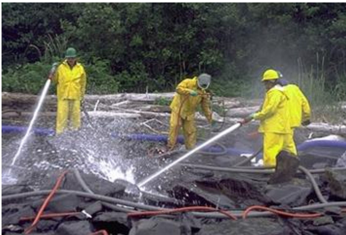
Figura 10 – Aplicação da técnica de jateamento a alta pressão com água quente no acidente do Exxon Valdez , 1989. Fonte: NOAA. Disponível em: < http://response.restoration.noaa.gov/oil-and-chemical-spills/significant-incidents/exxon-valdez-oil-spill/high-pressure-hot-water-washing.html >. Acesso em: 12 nov. 2013
