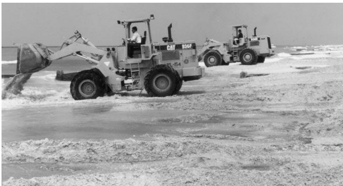
Figura 9 – Fotografia da relocação dos substratos para mais perto das ondas em 21 ago. 1993, Flórida. Fonte: Owens (1999).
