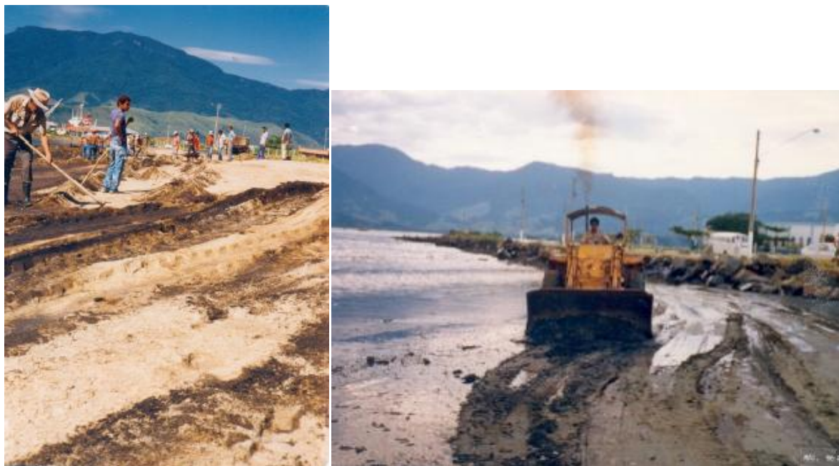
Figura 6 e 7 – Aplicação das técnicas de remoção manual e remoção mecânica, respectivamente. Fonte: CETESB (1986).
