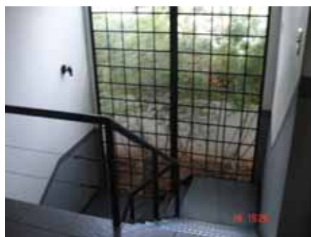
Figura 10 – Escada entre escritórios.
