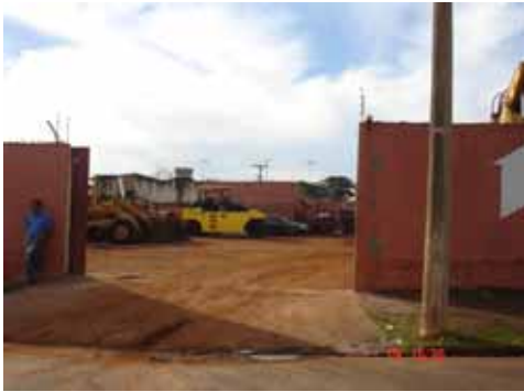
Figura 19 – Saída para Rodovia BR-050
